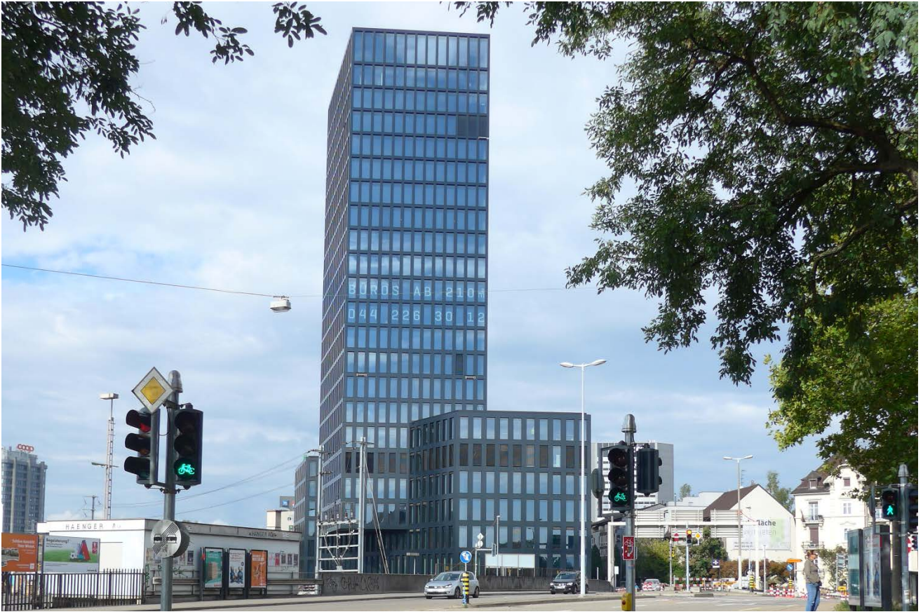
Abb. 4.3.2-08: Petermann Tower, Basel mit einer Gebäudehüllenfläche aus CIGS-Modulen
