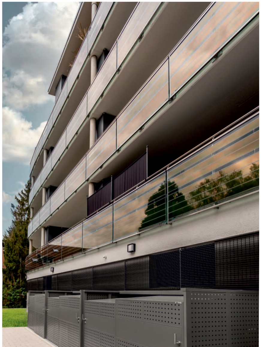
Abb. 7.4-07: Je nach Lichtverhältnissen schimmern die grünlich transparenten OPV-Brüstungselemente von außen in einem anderen Farbton.
