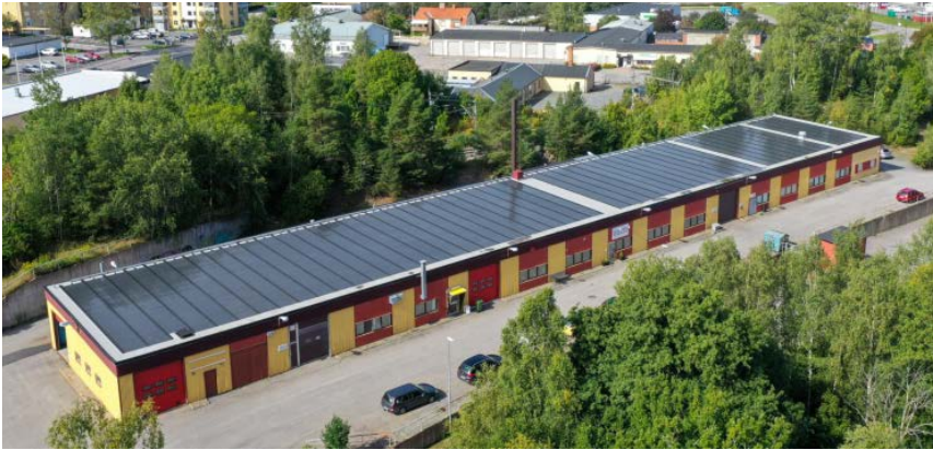
Abb. 7.2.3-05: Industriehalle mit Flachdach und 1.700 m 2 integrierten Midsummer BOLD®-Module (CIGS), Schweden, 158 kWp
