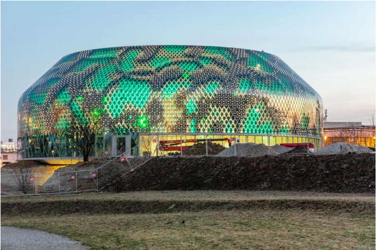
Abb. 8.3-03 Sichtbare Außenhülle des Gebäudes mit sichtbarem Gittertragwerk und OPV
