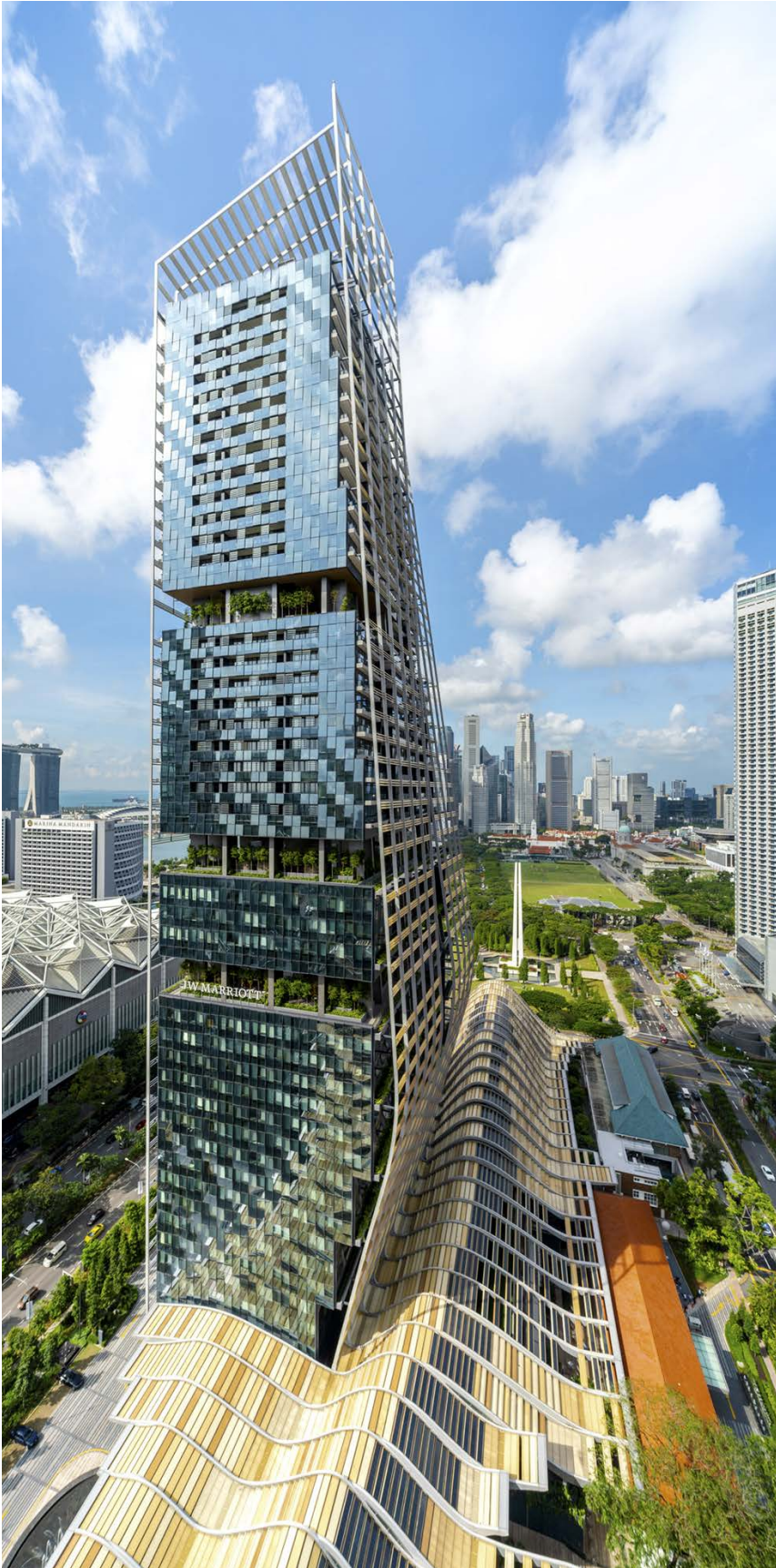
Abb. 8.2-01: South Beach Projekt mit in das Vordach integrierten schwarzen CIGS-Modulen
