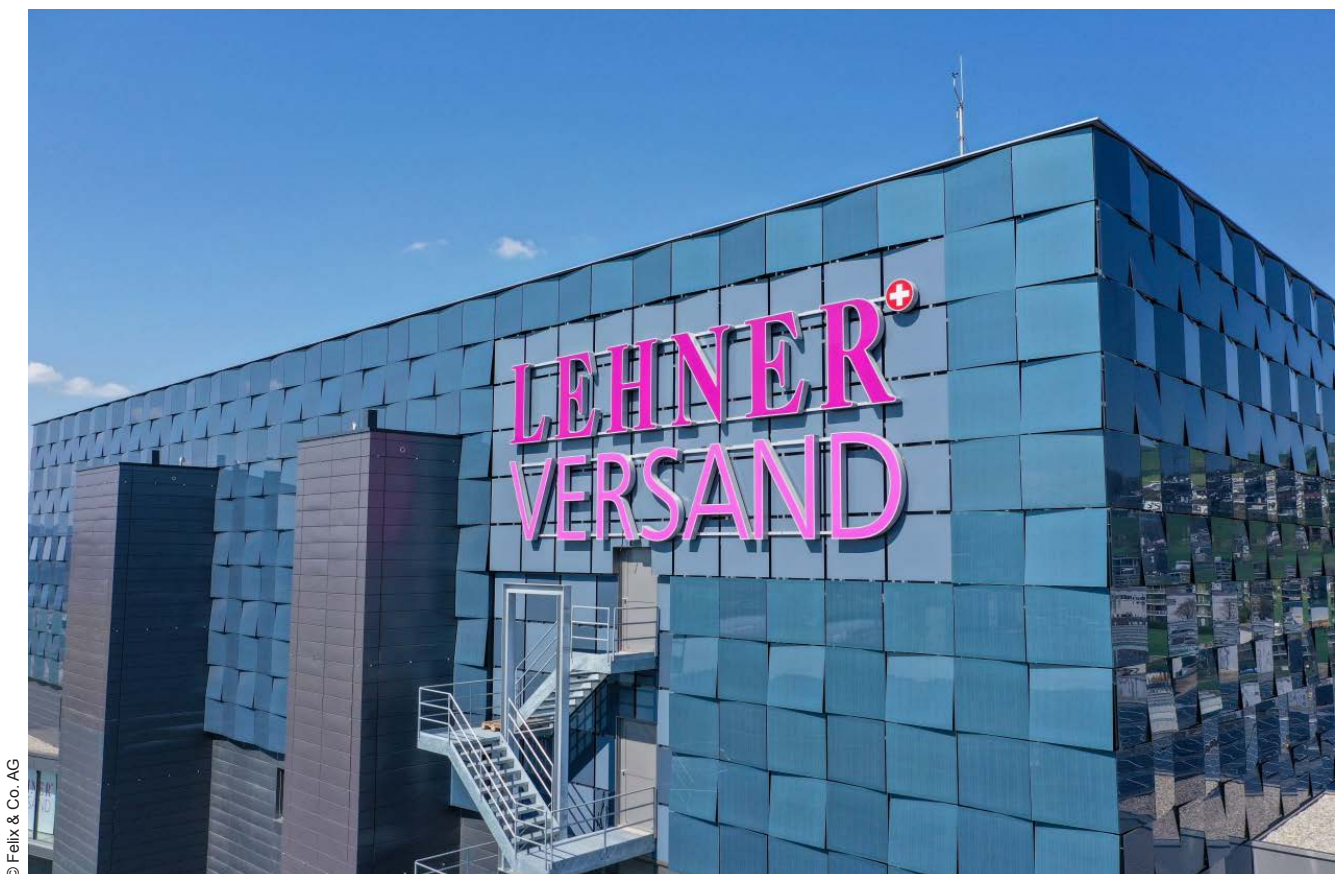
Abb. 5.8-06: Detail PV-Fassadenverkleidung im Farbton „Blau - Grau - Grün“, Lehner Versand AG, Schweiz
