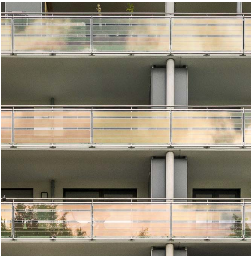
Abb. 7.5.2.2-02: OPV-Balkonverglasung als erster Schritt in die Richtung von ganzen Glassfassaden mit integrierter OPV
