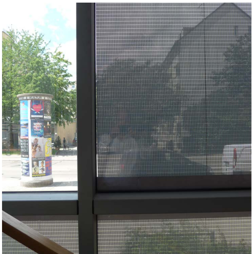
Abb. 4.3.1-06: Detail semitransparentes a-Si Isolierglasmodul, Kulturzentrum Milbertshofen
