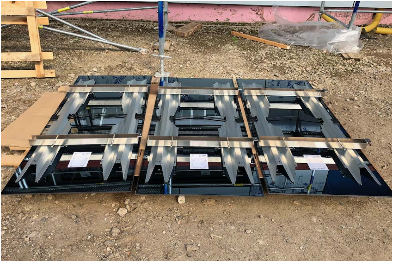
Abb. 7.3.2.3-07: Für die Montage vorbereitete CIGS-Fassadenmodule
