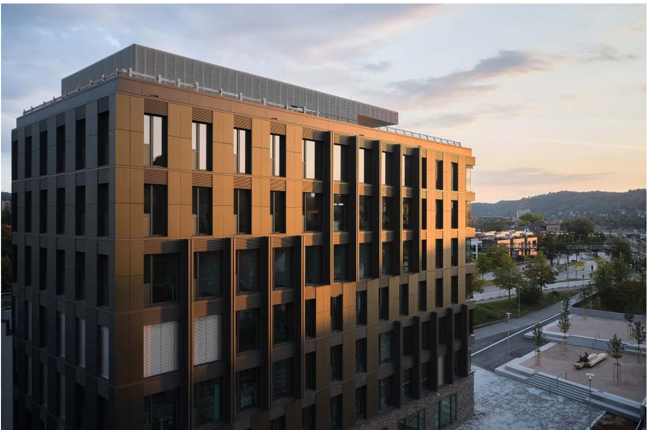
Abb. 3.4-08: Die Westspitze, Bürogebäude mit Nutzungsmischung in Holz-Hybridbauweise mit einer kompletten CIGS-Fassadenverkleidung, Tübingen
