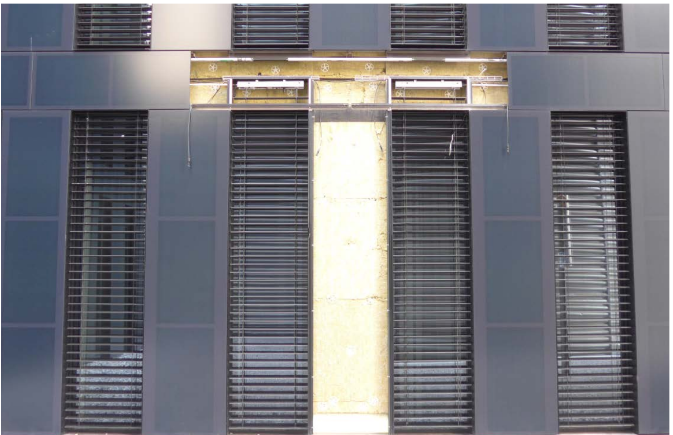
Abb. 4.3.2-09: Drei einzelnen CIGS Module wurden an dieser Stelle zu einem Fassadenverkleidungselement zusammengesetzt
