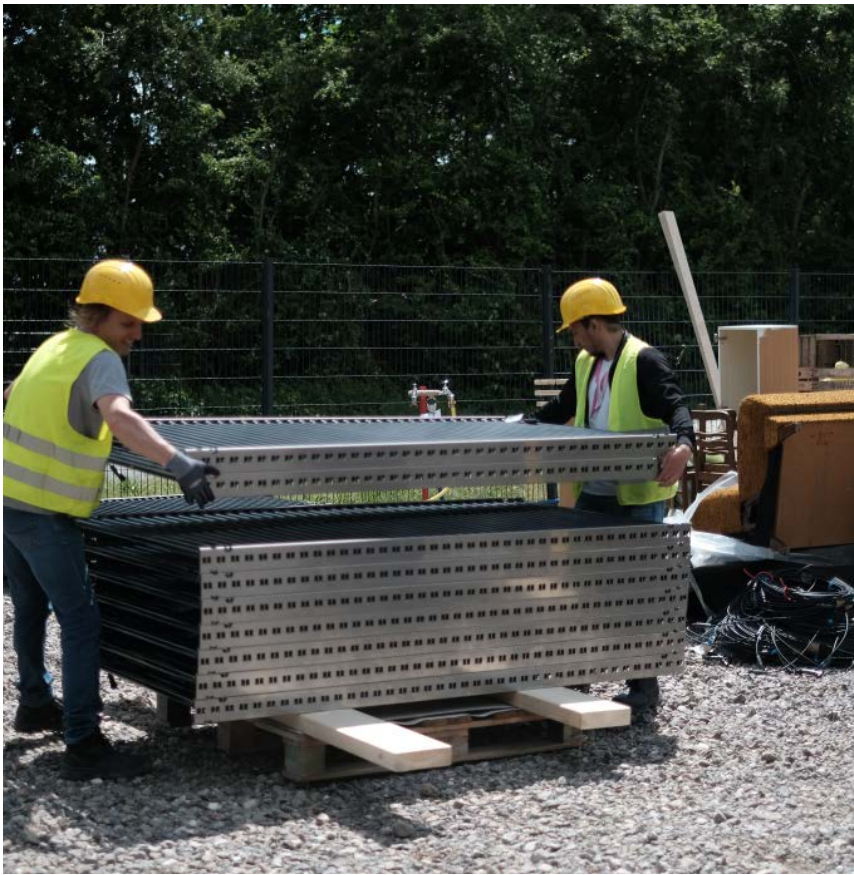
Abb. 7.6.1-10: Transport der relativ leichten Röhrensolarmodule
