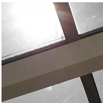
Abb. 7.5.2.4-11: Detail Cd-Te-Verglasung mit 3-fach Isolierglasmodulen von Sanko Solar, Objekt Waldstetten
