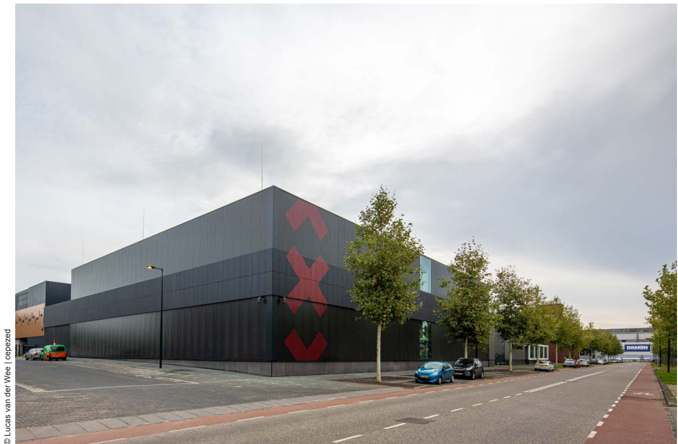
Abb. 8.1-02: Blick entlang der Straße mit dem Depot Amsterdam Nord und seinem PV-Band aus fassadenintegrierten CIGIS-Modulen
