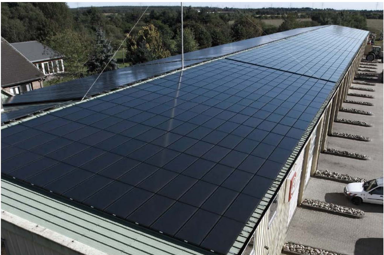
Abb.7.1.2.1-05: Dachaufständerung mit gerahmten CIGS-Modulen, Landwirtschaftshalle Handewitt, 198,9kWp
