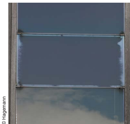
Abb. 9-03: Delaminationserscheinungen bei fortschreitender Alterung
