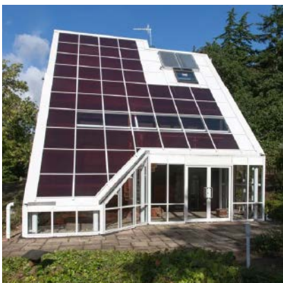
Abb. 4.3.1-03: Außenansicht mit Dach aus a-Si Modulen, Integer-House, BRE Smart
