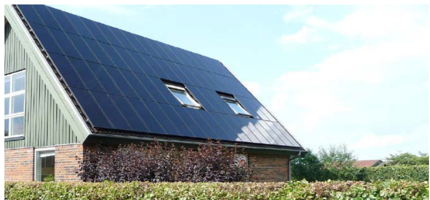
Abb. 7.1.2-01: Aufdachmontage mit Avancis PowerMax
