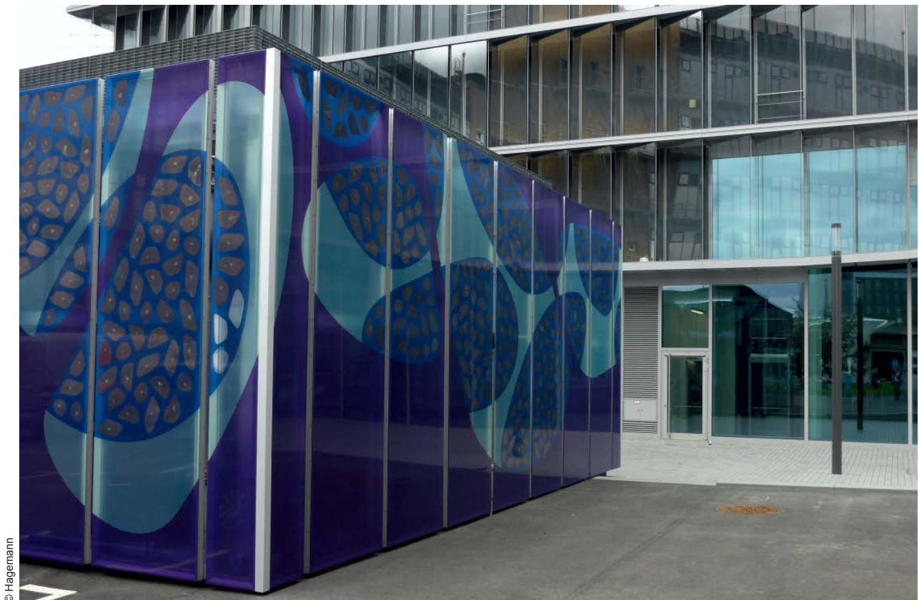
Abb. 4.3.5-08: ETFE-Fassade mit integrierten, transparenten OPV-Zellen (ASCA SAS), Betriebsgelände Merck KGaA, Darmstadt
