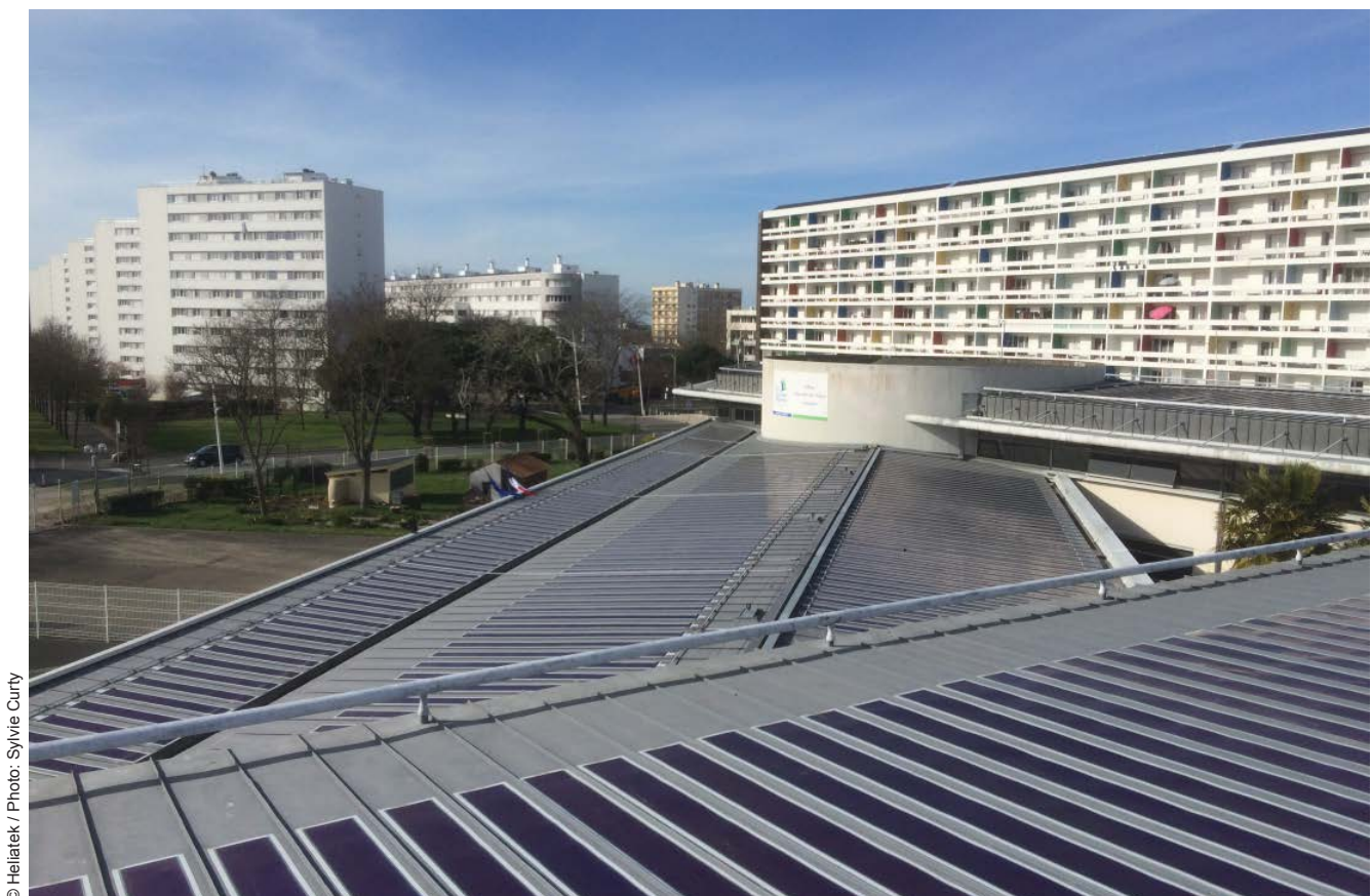
Abb. 7.1.2.2-16: Ansicht der Stehfalzdeckung mit integrierten Dachinstallationen mit HeliaSol®-Modulen, Schuldach, La Rochelle, Frankreich
