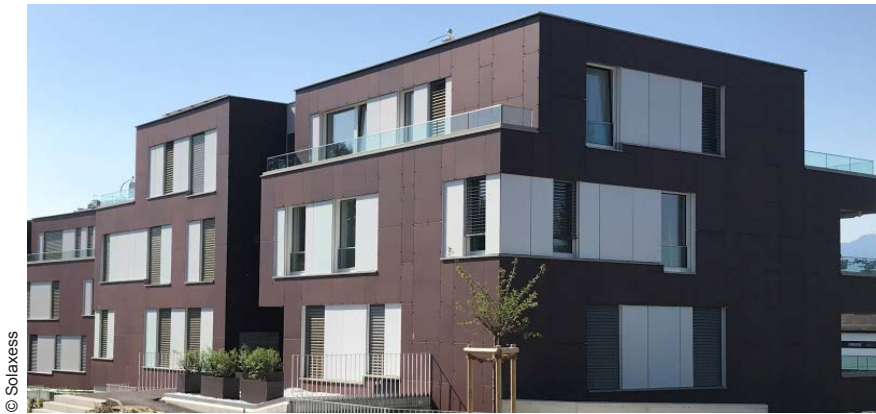
Abb. 5.9-04: Weiße PV-Fassadenmodule mit Solaxess Technologie, CO 2 -neutrale Wohnsiedlung, Männedorf, Schweiz
