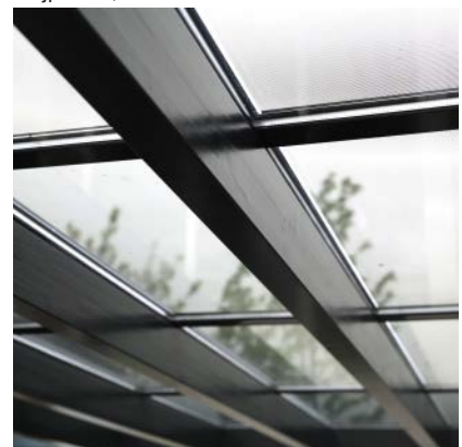
Abb. 7.5.2.4-03: Detail CdTe-Verglasung, Transparenzgrad 20 %
