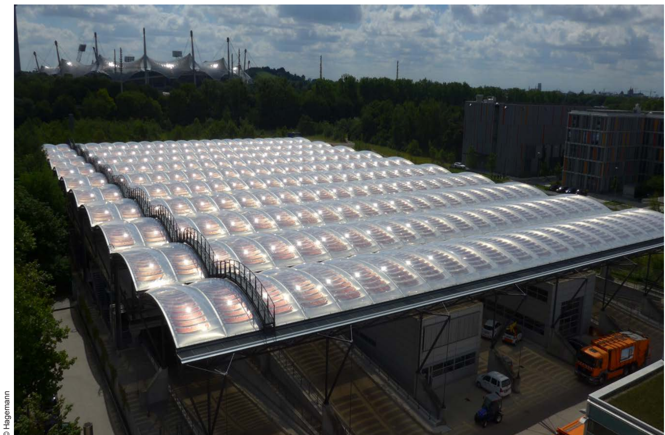
Abb. 7.7.1-04: ETFE-Luftkissen mit integrierten a-Si-Modulen in der 2. Luftkissenebene, Abfallwirtschaftsbetrieb München (AWM), 145 kWp
