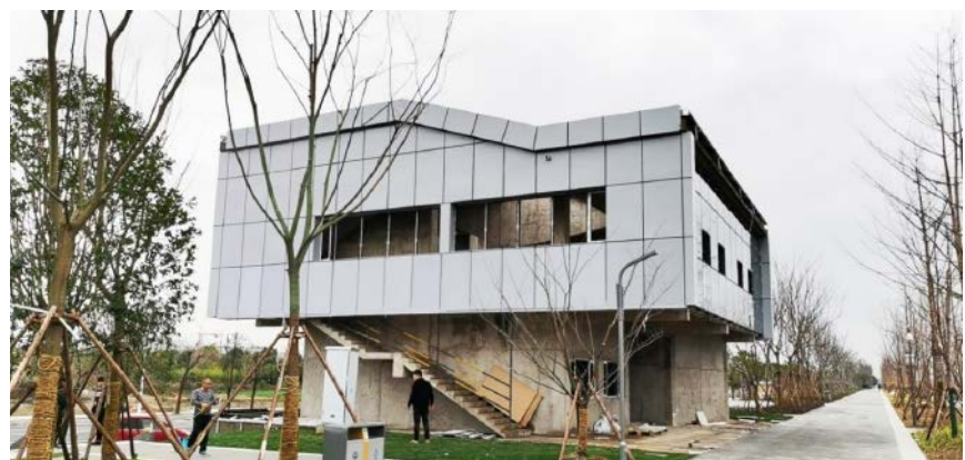
Abb. 5.9-03: Verkleidung der gesamten Gebäudehülle mit weißen PV-Modulen mit Solaxess Technologie, Villa, Quzhou, China
