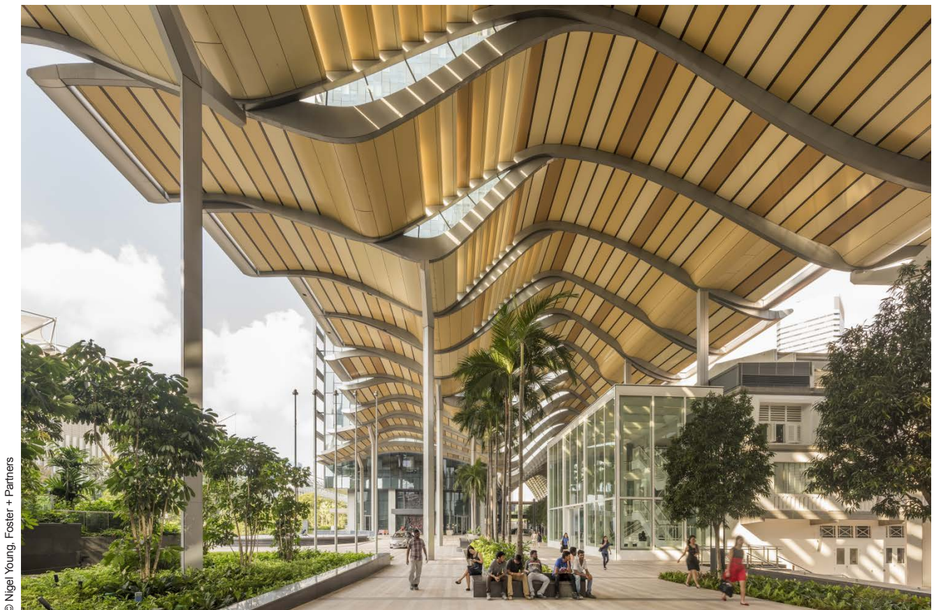
Abb. 8.2-02: Fußgängerbereich unter dem Vordach aus Lamellen
