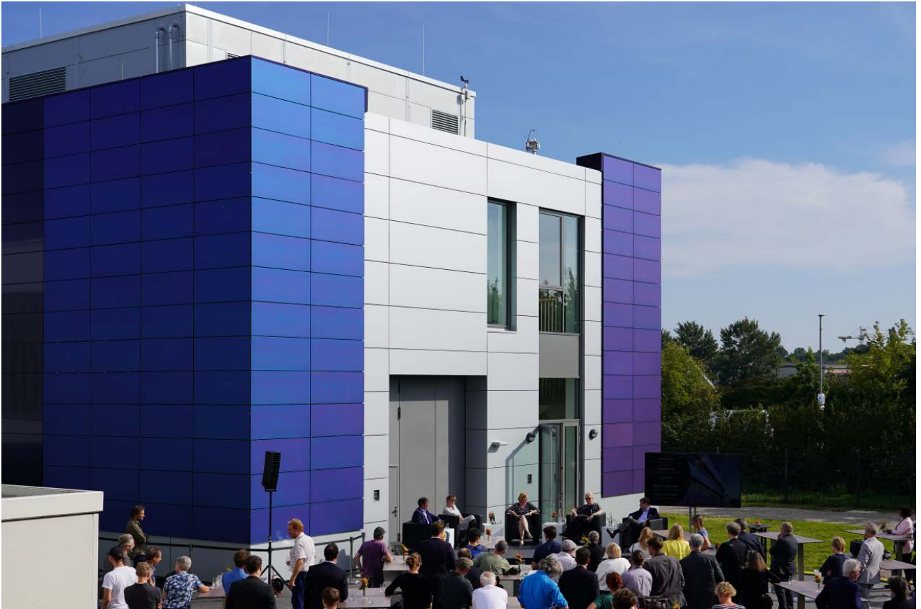
Abb. 7.3.2.3-05: CIGS-Fassadenverkleidung mit SKALA-Modulen im Farbton „SKALA Blau 7003“, Helmholtz Zentrums Berlin, 49kWp
