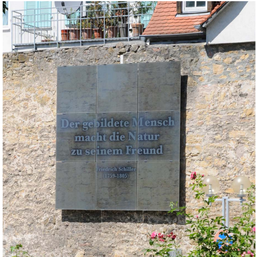
Abb. 5.5-04: CIGS-Module mit Siebdruck, Schiller-Zitat-Tafel, Marbach am Neckar,
