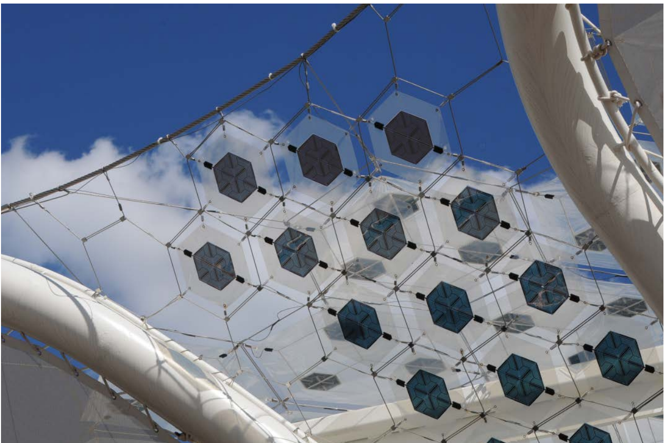
Abb. 7.8-07: Drahtseilnetz mit eingehängten, sechseckigen bläulich transparenten OPV-Bauelementen
