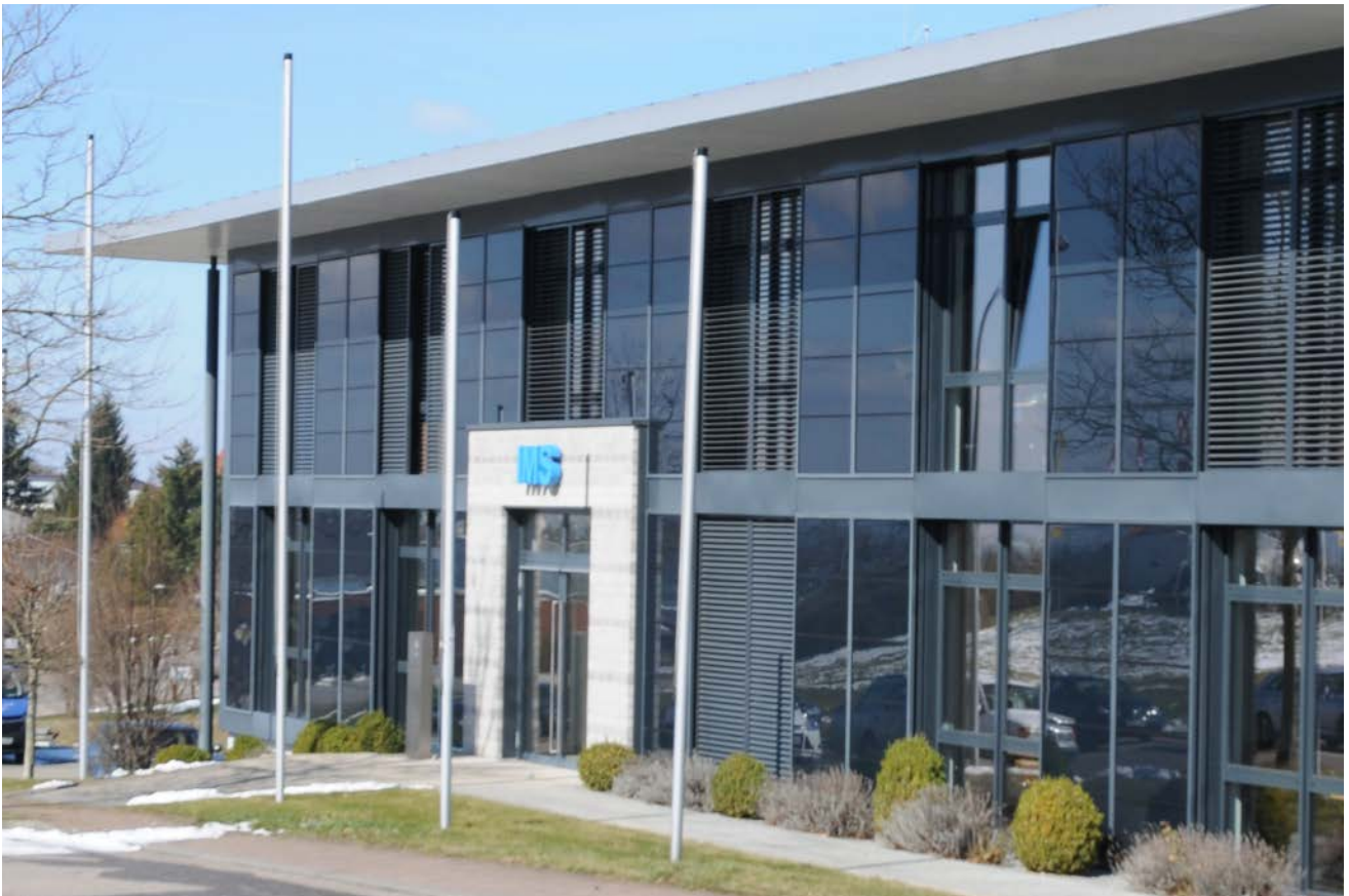
Abb. 4.3.2-12: CIGS-Fassadenverkleidung, IMS Verbindungstechnik, Neuenstein, 6 kWp, 65 m 2
