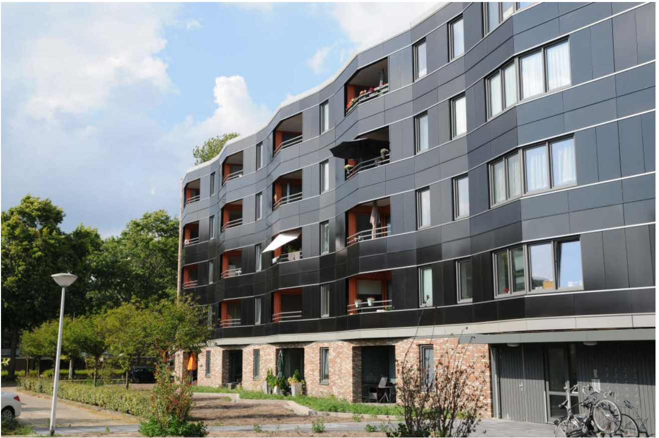
Abb. 3.4-07: CIGS-Fassadenverkleidung, Wohnbebauung, Best, Niederlande
