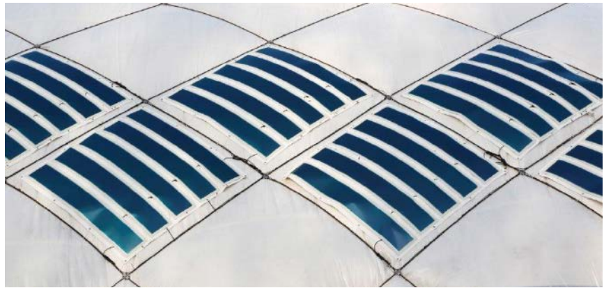
Abb. 7.7.1-02: Detail der einzelnen 2x2m großen Modulfelder. Montage der Module mit flexiblen Bändern an den Stahlseilen der Hallenkonstruktion.
