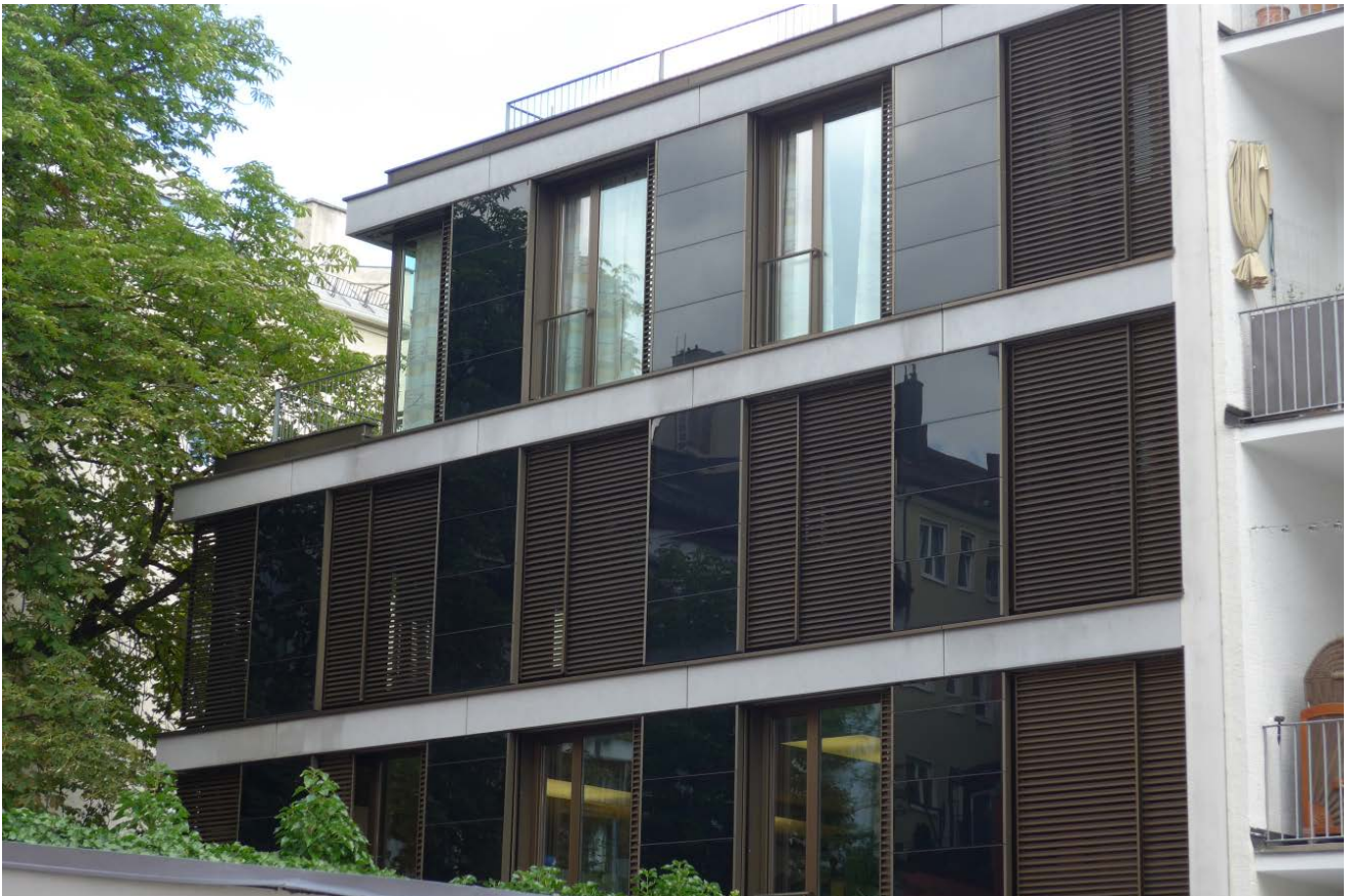
Abb. 7.3.2.1-01: CIGS-Fassadenverkleidung, 4,2kWp
