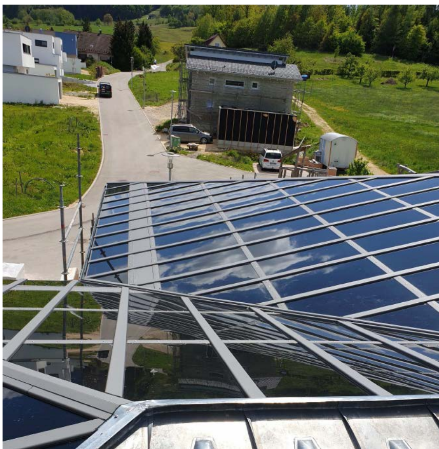
Abb. 7.5.2.4-10: Außenansicht Oberlichtverglasung mit semitransparenten CdTe-Isolierglasmodulen von Sanko Solar, Objekt Waldstetten
