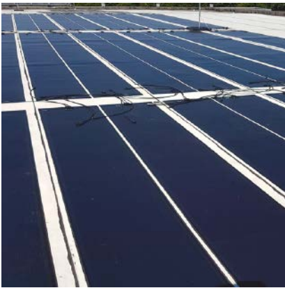
Abb. 7.2.3-04: Flisom eFlex® mit Membranabdichtung, Öffentliches Schwimmbad, Niederland, 100 kWp
