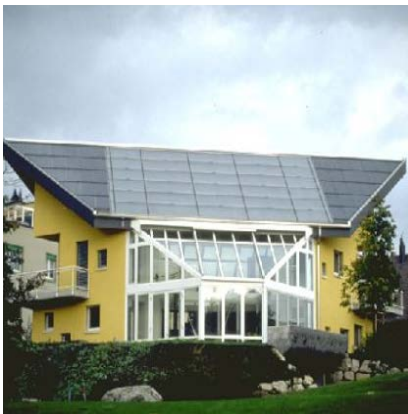
Abb. 2.2-01: Dach mit PV+Solarthermiekollektoren, Haus „Kästli“, Zollikofen, Schweiz
