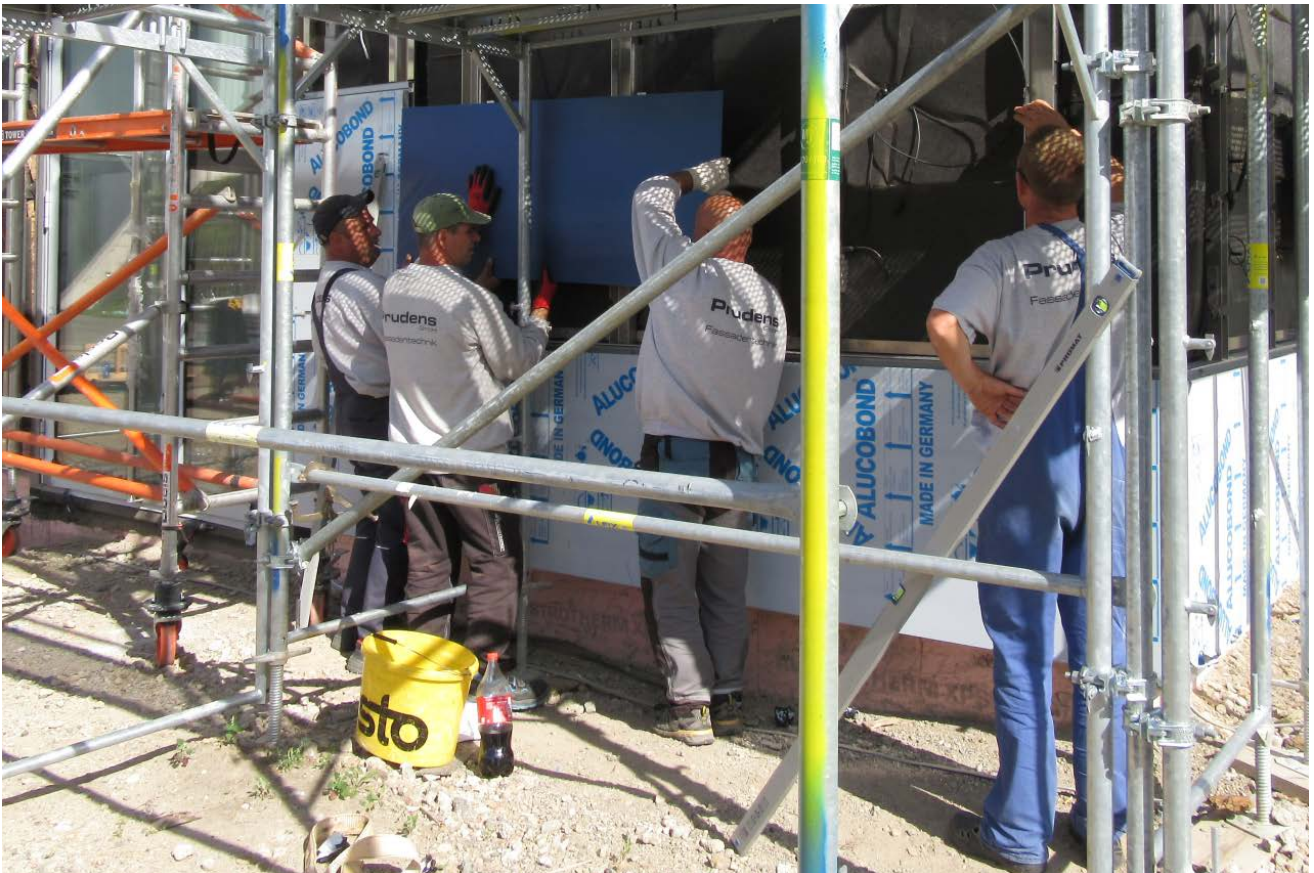
Abb. 7.3.2.3-09: Montage der vorbereitete CIGS-Fassadenmodule
