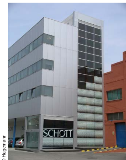
Abb. 5.2-02: Außenansicht des Treppenhaus mit farbigen a-Si Isolierglasmodulen, Betriebsgebäude Schott Iberica
