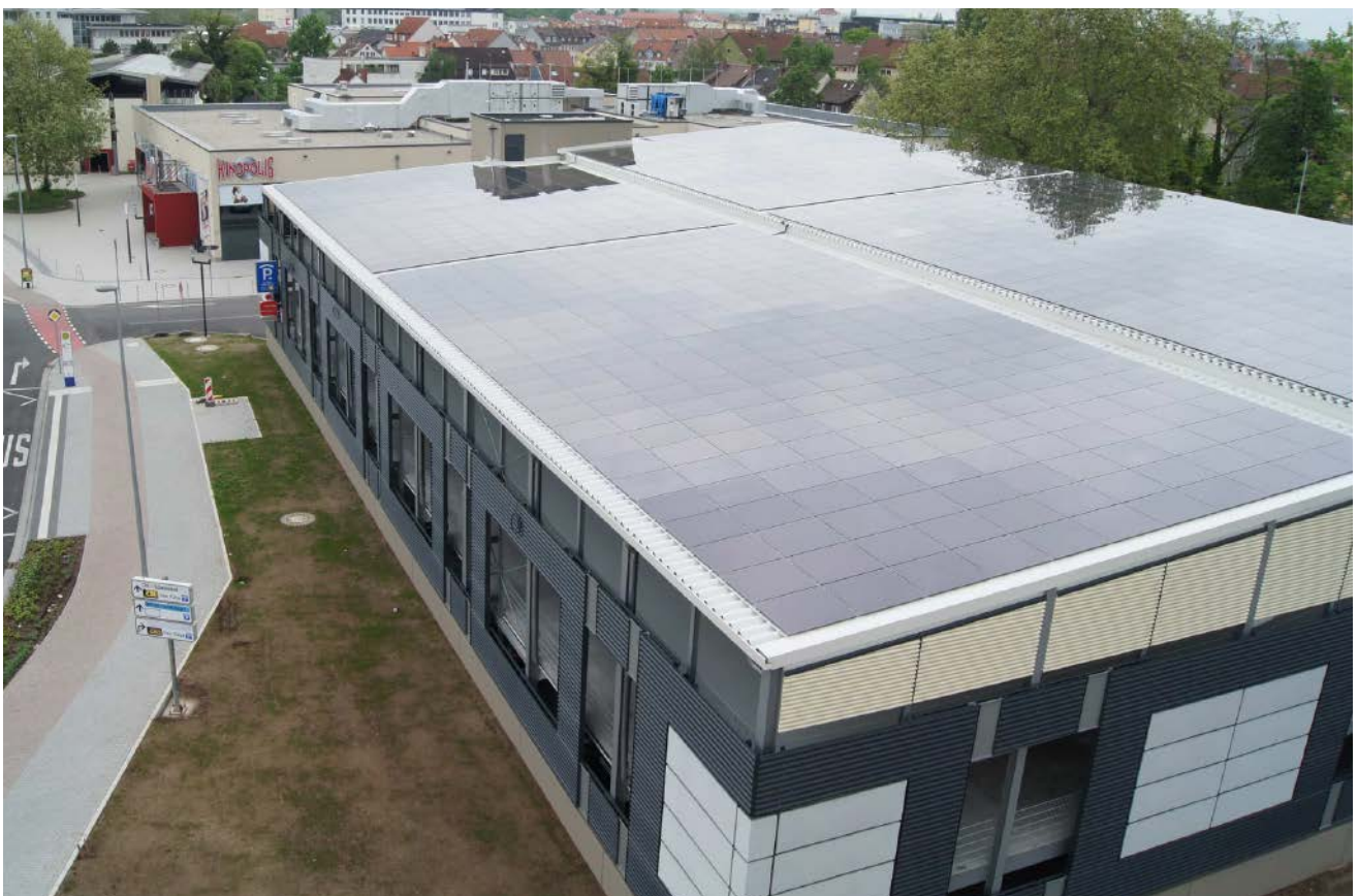
Abb. 7.1.1-01: Pultdach mit aufgeständerte Dünnschicht-PV-Anlage, Parkhaus Kinopolis, Hanau
