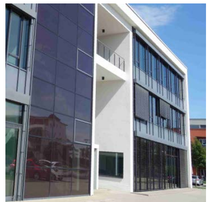
Abb. 6.4-03: Isolierglasfassade mit Dünnschicht PV (a-Si)
