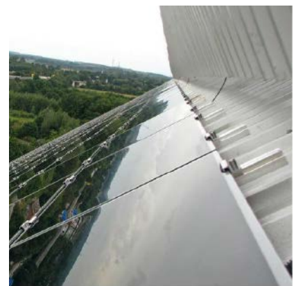
Abb. 7.1.2.1-07: Detail. Modulaufständering, Riedel Recycling GmbH
