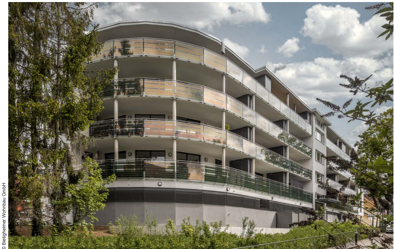
Abb. 7.4-02: OPV-Brüstungselemente, 10 kWp
