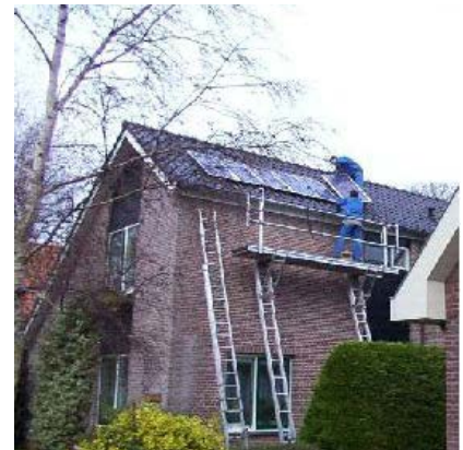
Abb. 9-07: Gefahrenquelle Modulmontage
