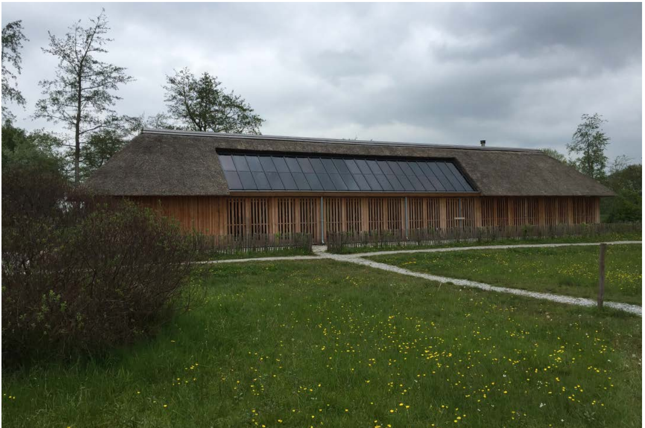
Abb. 7.5.2.4-04: Über-Kopf-Verglasung mit semitransparenten CdTe-Modulen, Transparenzgrad 20%, Objekt
