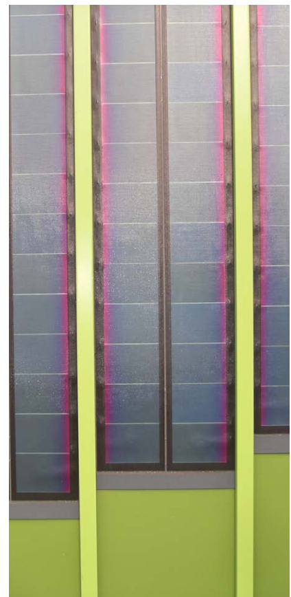
Abb. 7.3.1-03: Detail der aufgeklebten flexiblen a-Si-Dünnschichtsolarmodule
