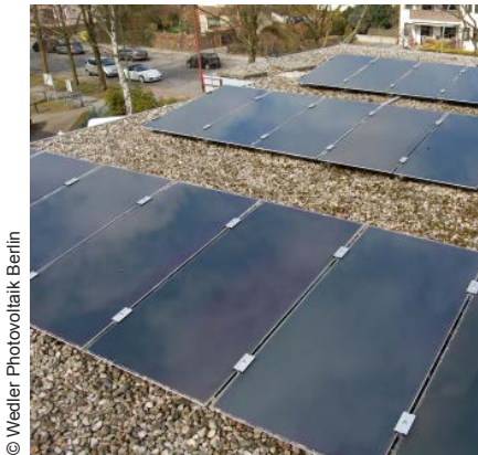
Abb. 7.2.1-02: PV-Dachaufständerung mit nach Süden ausgerichteten a-Si-Glasmodulen
