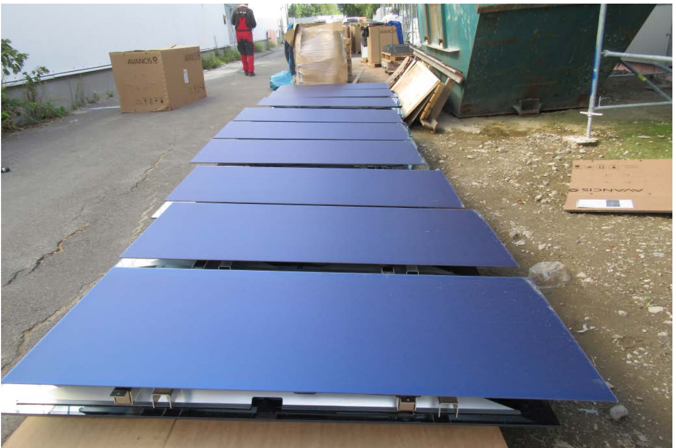
Abb. 7.3.2.3-06: CIGS-Fassadenmodule vor der Montage, Farbton „SKALA Blau 7003“
