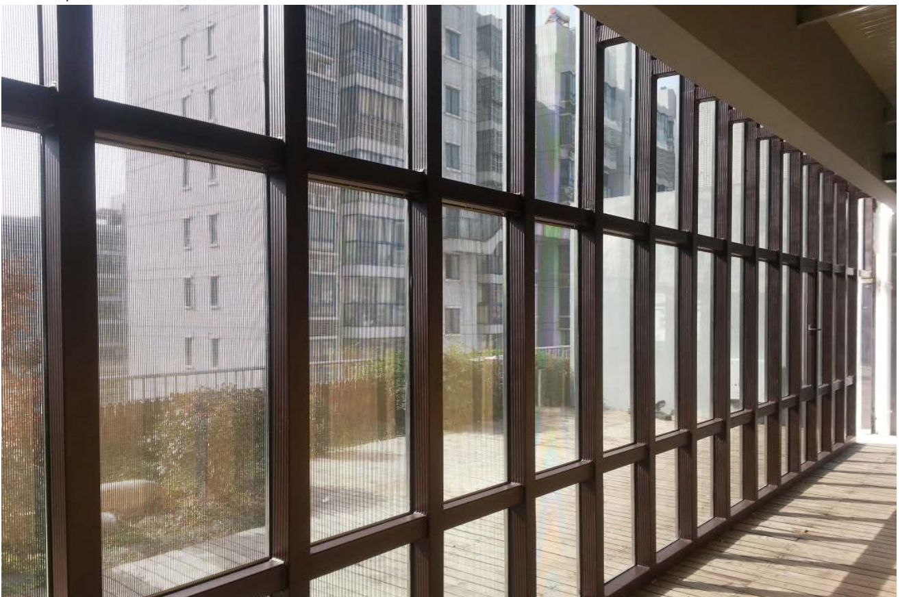
Abb. 7.5.2.1-04: Lichteffekte durch direktes Sonnenlicht bei einer semitransparenten Glasfassade CdTe-Zellen. Schlagschatten wird nur durch die Pfosten-Riegel-Profile geworfen, nicht aber durch die CdTe-Module selbst.
