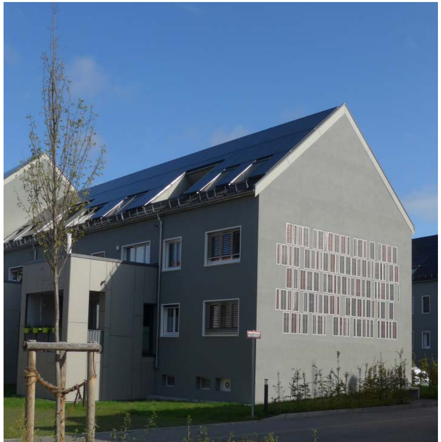
Abb. 7.3.3-02: Gebäudefassade mit Wärmedämmverbundsystem (WDVS) und interrierter OPV
