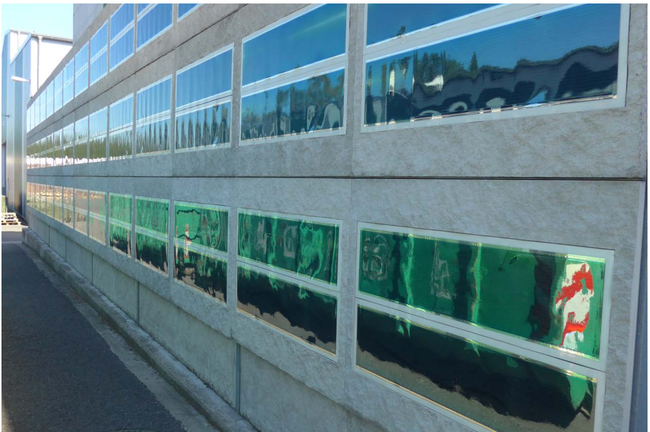
Abb. 4.3.5-14: Fassadenplatten aus Beton mit OPV, Testgelände, Reckli GmbH, Herne
