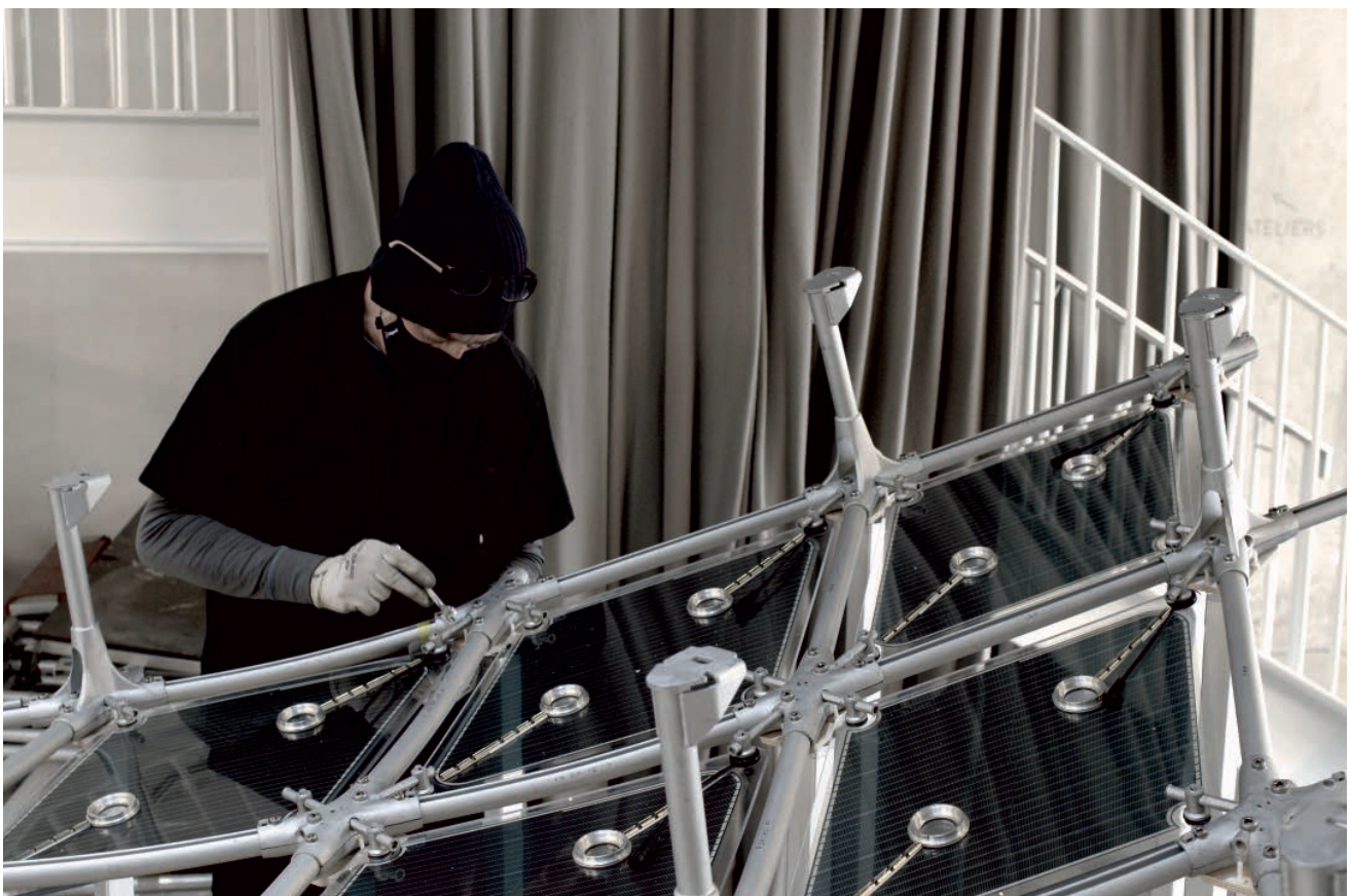
Abb. 8.3-11: Vormontage der OPV-Fassadenelemente
