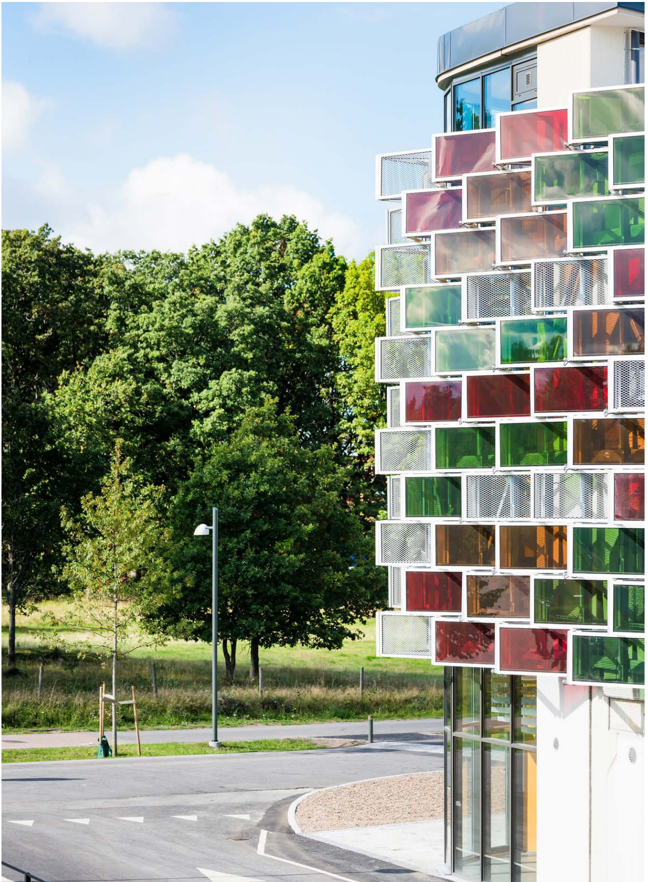
Abb. 5.1-03: Farbige, semitransparente CdTe-Module, Parkhaus, Vallastaden, Schweden / Produkt: „Soltech Facade - Semitransparent“, Soltech
