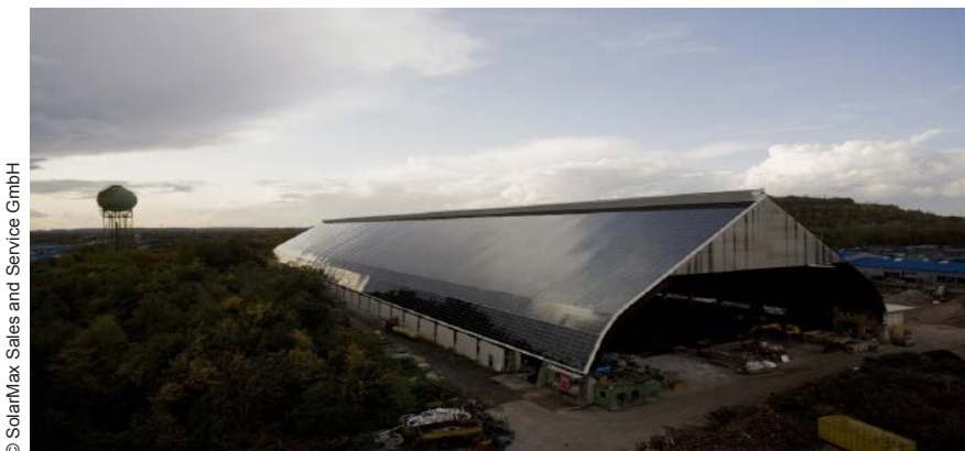
Abb. 2.1-01: PV-Dachaufständerung, Kohlenmischhalle der Zeche Pattberg, heute Riedel Recycling GmbH, mit 11.467 CdTe-Modulen
