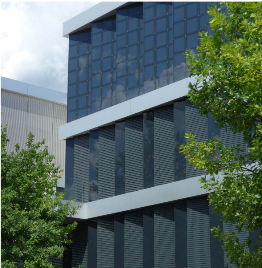
Abb. 4-01: 600m 2 PV-Fassadenverkleidung mit CIGS Modulen, Gesamtleistung 600 kWp, ERBE Tübingen
