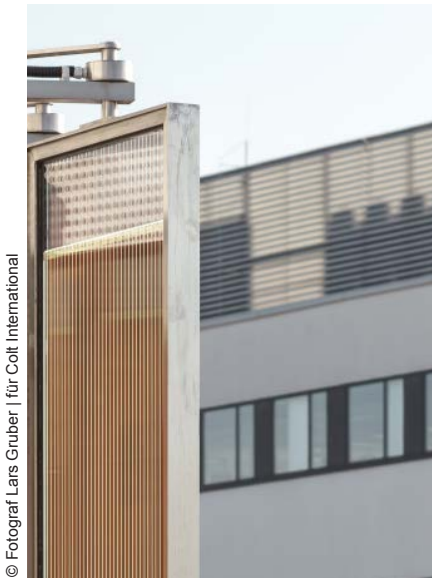
Abb. 7.6.2-10: Detail des feststehenden vertikalen Sonnenschutzes
