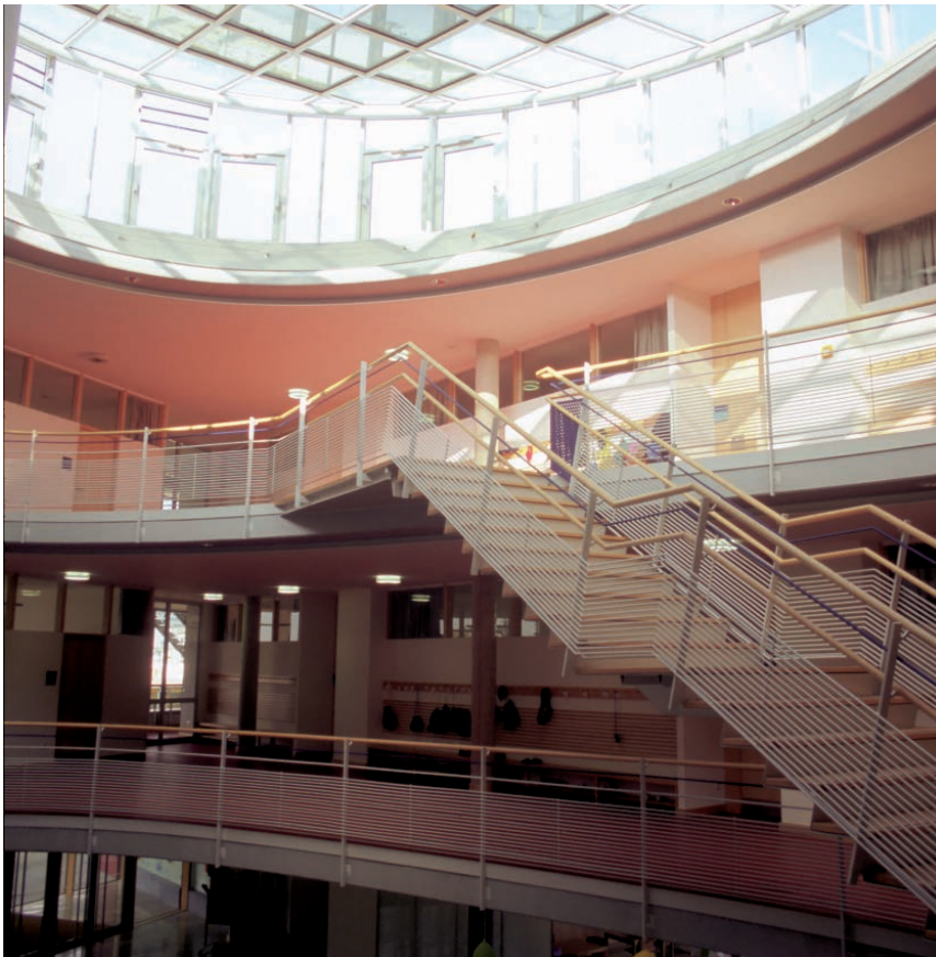
Abb. 7.5.2.4-13: Innenansicht Oberlichtverglasung mit a-Si-Isolierglasmodulen, 52 m 2 , 2,4 kWp
