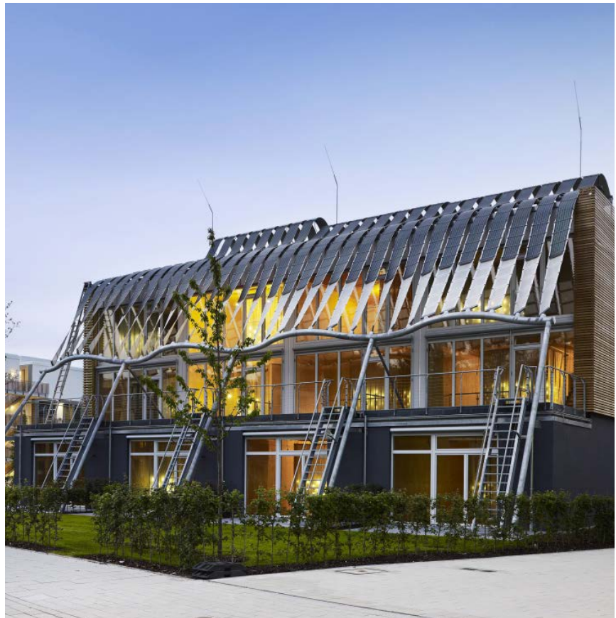
Abb. 2.2-09: Stadtentwicklung im Rahmen der IBA Hamburg. Softhouse: Dynamische Textilfassade mit integrierten CIGS-Modulen, Kennedy & Violich Architecture
