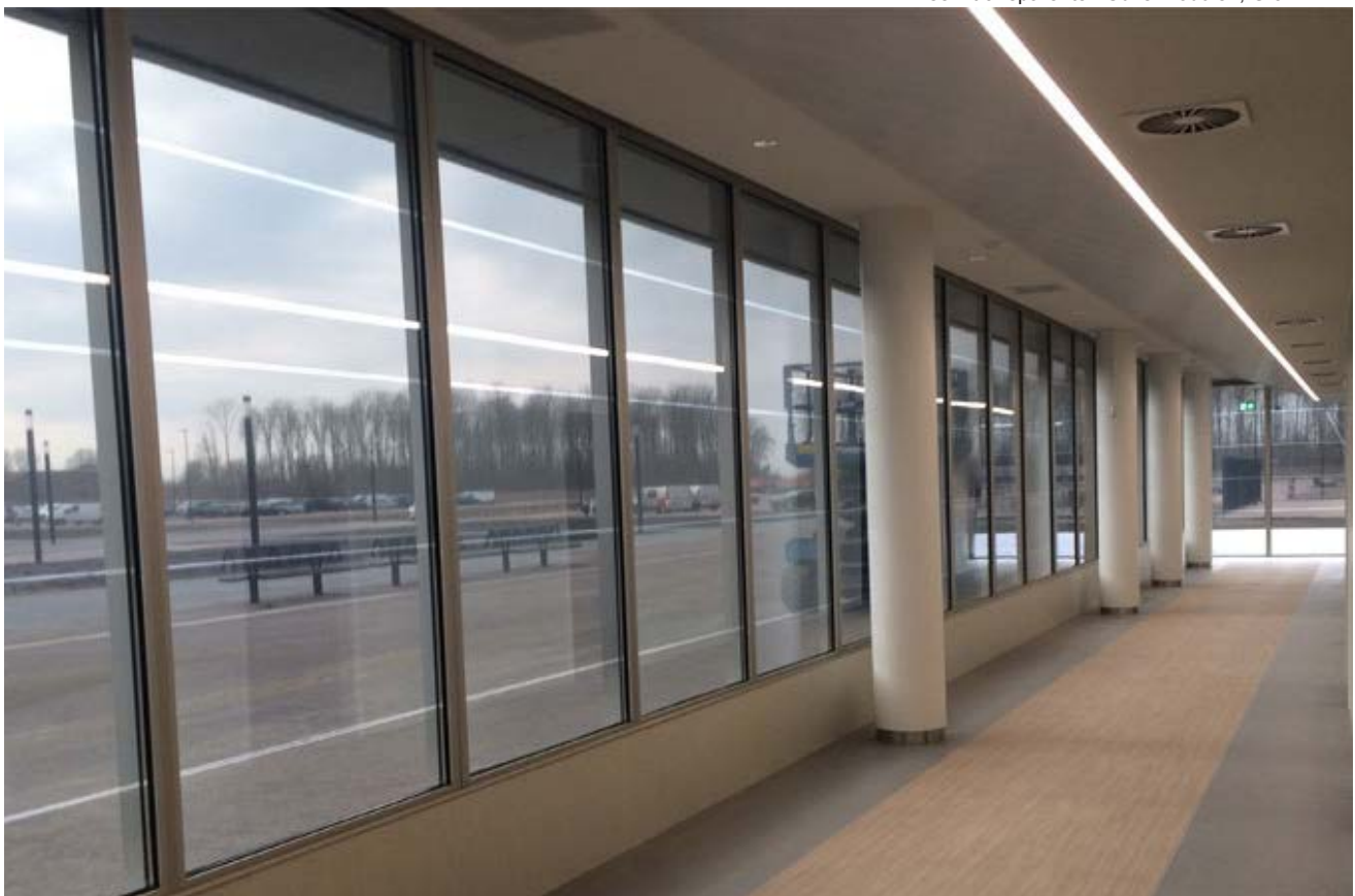
Abb. 7.5-02: Semitransparente CdTe-Glasfassade mit einem Transparenzgrad von 20%, Krankenhaus, Scheemda, Niederlande
