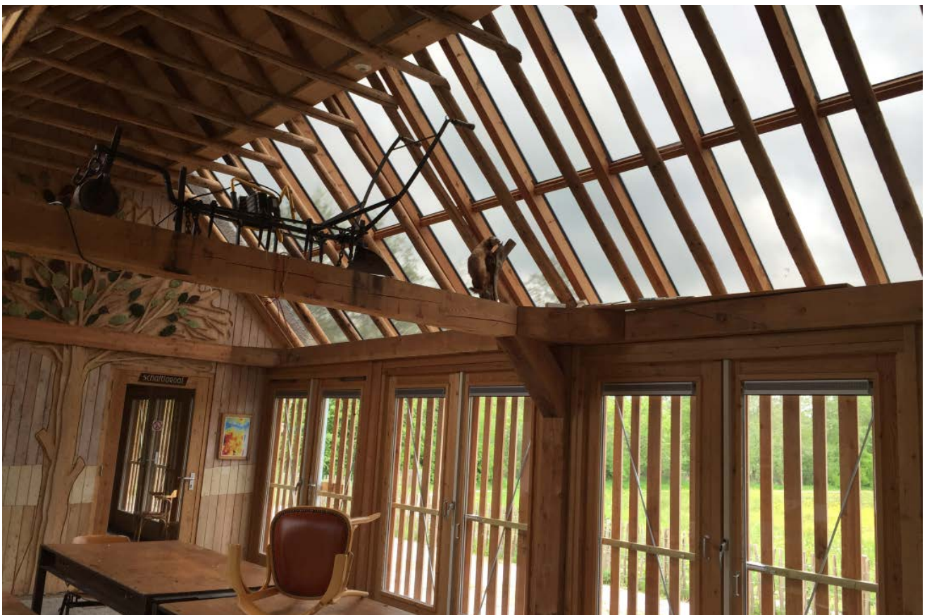
Abb. 7.5.2.4-05: Ansicht von Innen, Über-Kopf-Verglasung mit semitransparenten CdTe-Modulen, Transparenzgrad 20%, Objekt
