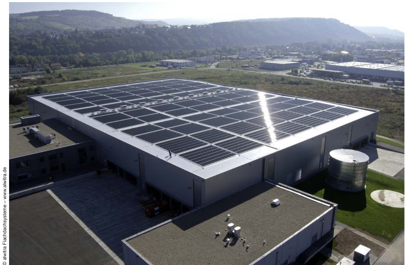
Abb. 4.3.2-05: Flachdach mit Solyndra Modulen, Parts Europe, Wasserliesch
