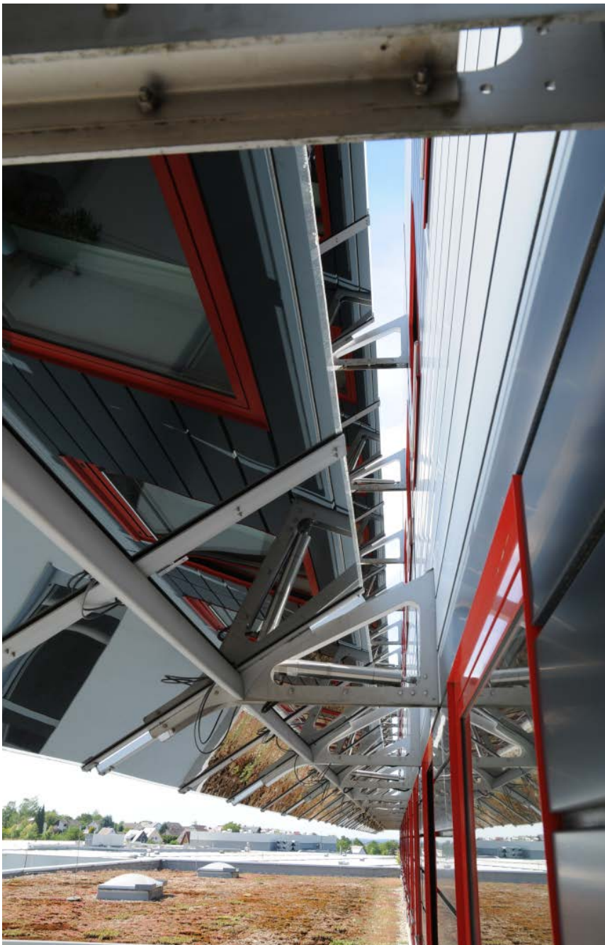
Abb. 7.6.2-06: Nachführbares, CIGS-Sonnenschutzsystem, Würth Elektronik eiSos, Waldenburg,
