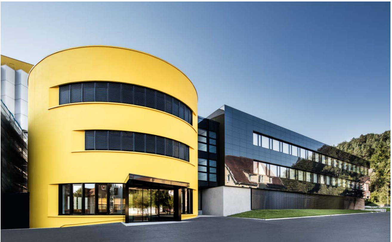
Abb. 6.2-09: Empfangsgebäude Sto-Unternehmenszentrale, Weizen mit hauseigenem vorgehängten hinterlüfteten Photovoltaik-Fassadensystem
