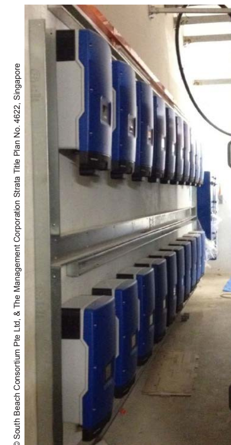
Abb. 8.2-10: Wechselrichter Wand 2
