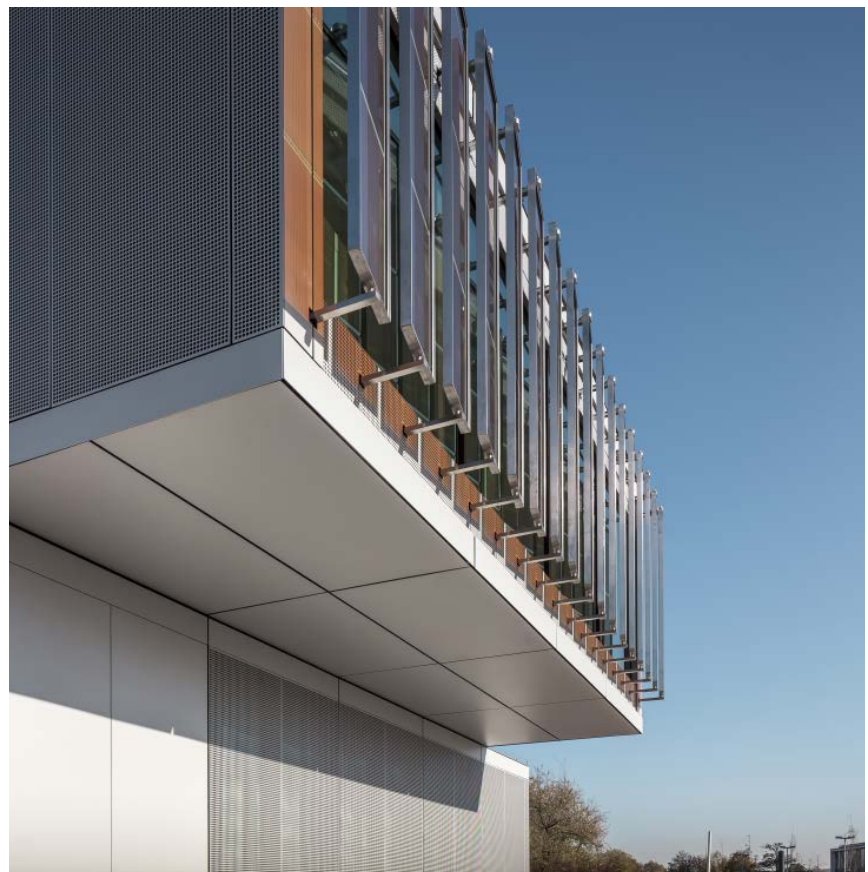
Abb. 6.3-01: Bewegliche „Shadovoltaik - Farbstoffstoffsolarzellen-Lamellen“ aus Glas der Firma COLT International, Merck KGaA, Darmstadt
