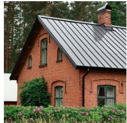
Abb. 7.1.2.2-12: Dachdeckung mit Midsummer SLIM®
