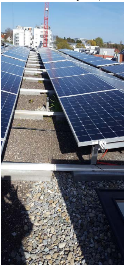
Abb. 7.4-04: Detail Dachaufständerung mit gerahmten kristallinen PV-Modulen
