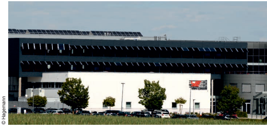
Abb. 7.6.2-04: Nachführbares, CIGS-Sonnenschutzsystem, Würth Elektronik eiSos, Waldenburg
