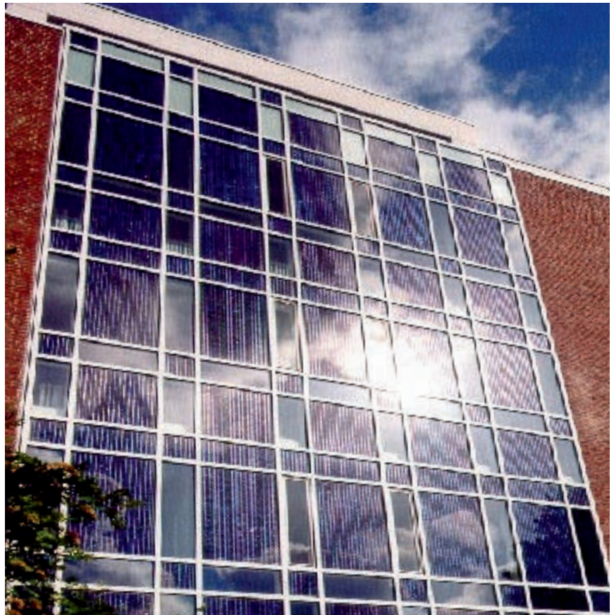
Abb. 2.3-03: Weltweit erstes Bürogebäude mit PV-Glasfassade, STAWAG, Aachen
