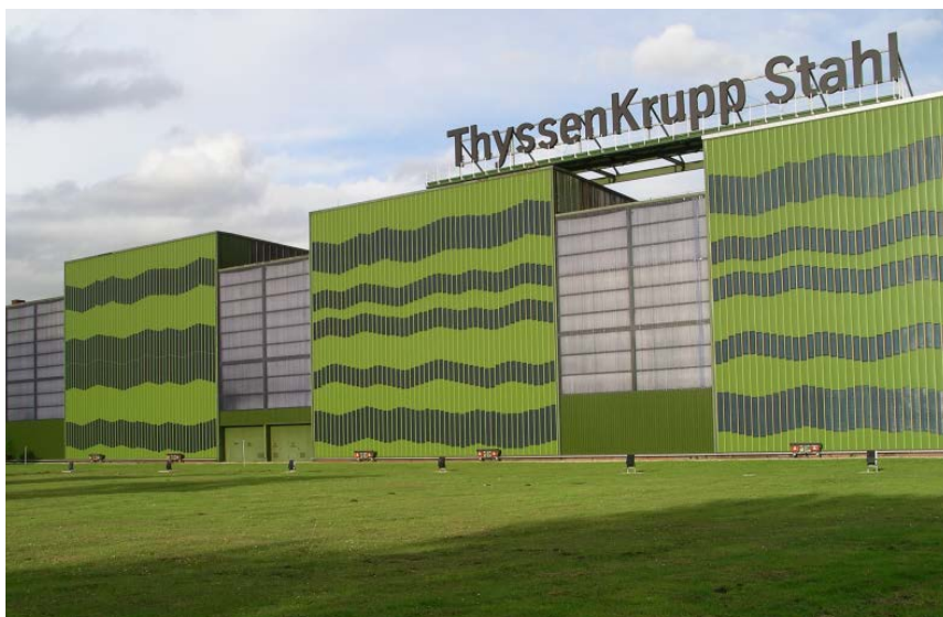
Abb. 2.3-01: PV-Wandverkleidung (a-Si), ThyssenKrupp Stahl, Duisburg (51 kWp)
