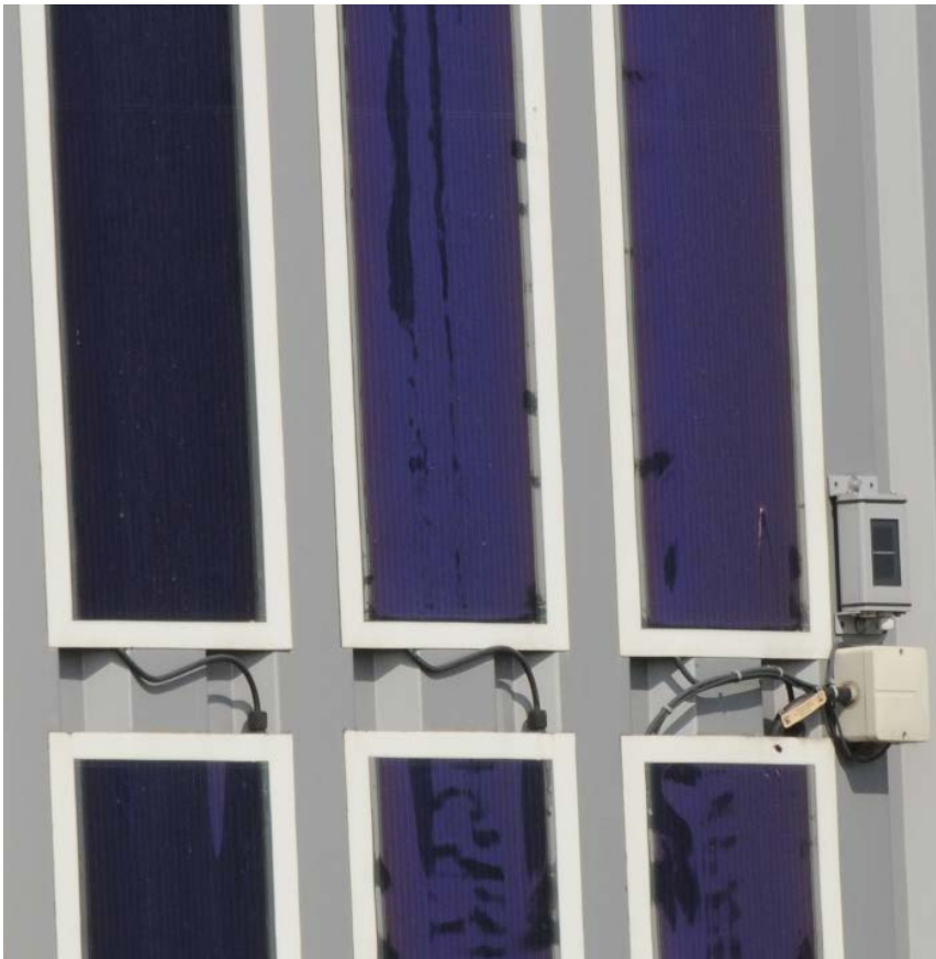
Abb. 7.3.1-06: Detail OPV-Module und Verkabelung
