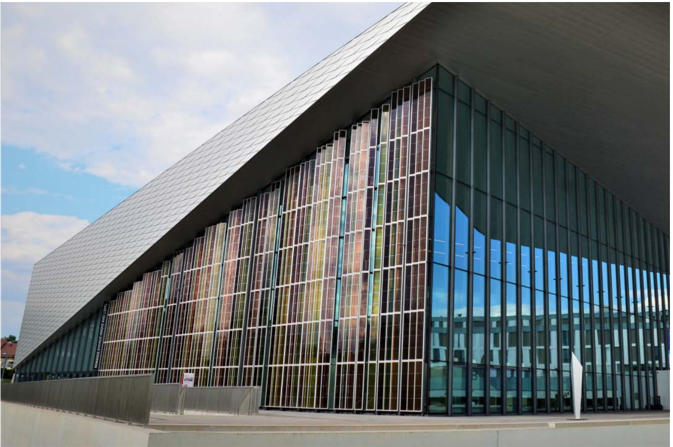
Abb. 5.11-03: Fassade mit Sonnenschutzlamellen aus Glas mit integrierten Farbstoffsolarzellen, SwissTech Convention Center, Lausanne,
