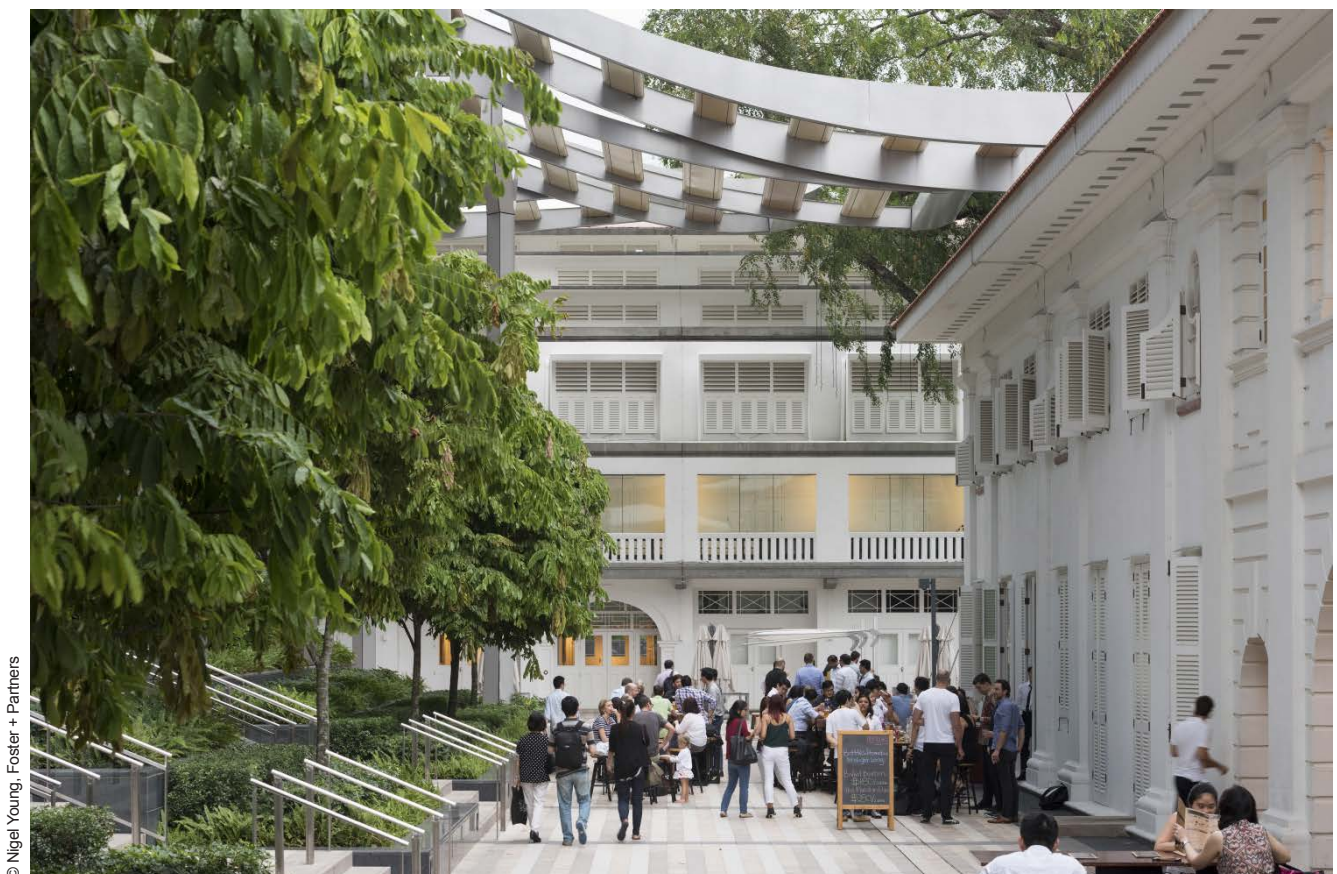
Abb. 8.2-03: Fußgängerbereich mit historischem Gebäude rechts und Vordach aus Lamellen
