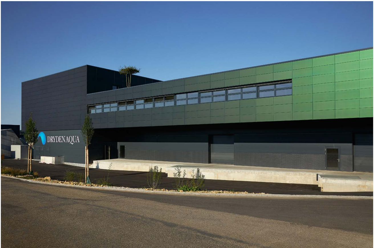
Abb. 7.3.2.3-03: CIGS-Fassadenverkleidung mit SKALA-Modulen im Farbton „SKALA Grün 4002“, Campus Aqua, Büsserach, Schweiz, 146,67 kWp
