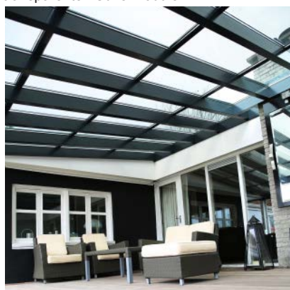
Abb. 4.3.3-09: Überkopfverglasung mit transparenten CdTe-Modulen
