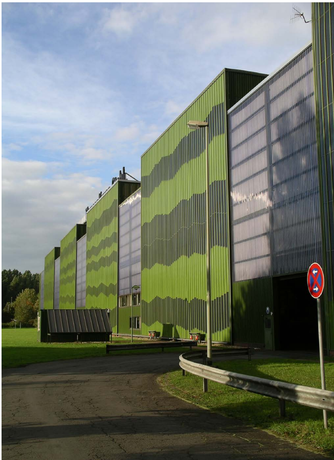
Abb. 7.3.1-01: Künstlerisch gestaltete PV-Fassade mit aufgeklebten flexiblen Dünnschichtmodulen, Thyssen-Krupp Steel Europe AG, Duisburg
