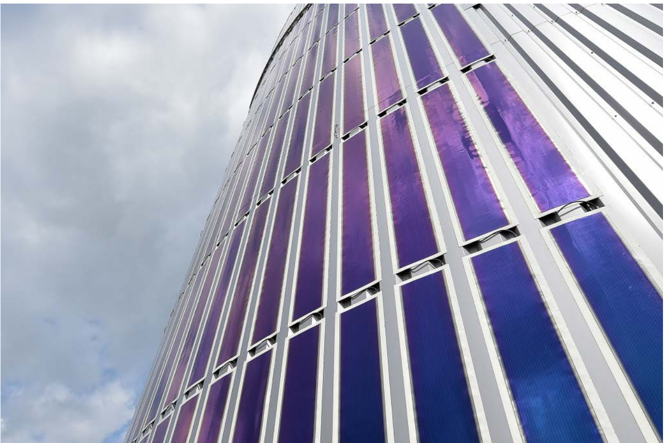
Abb. 7.3.1-05 HeliaFilm Folien mit einer Gesamtfläche von 95m 2 wurden direkt auf das profilierte Stahlblech aufgeklebt
