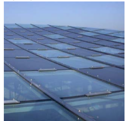
Abb. 7.5.2.4-15: Detail Oberlichtverglasung mit in Entwässerungsrichtung unterbrochenen Profilleisten
