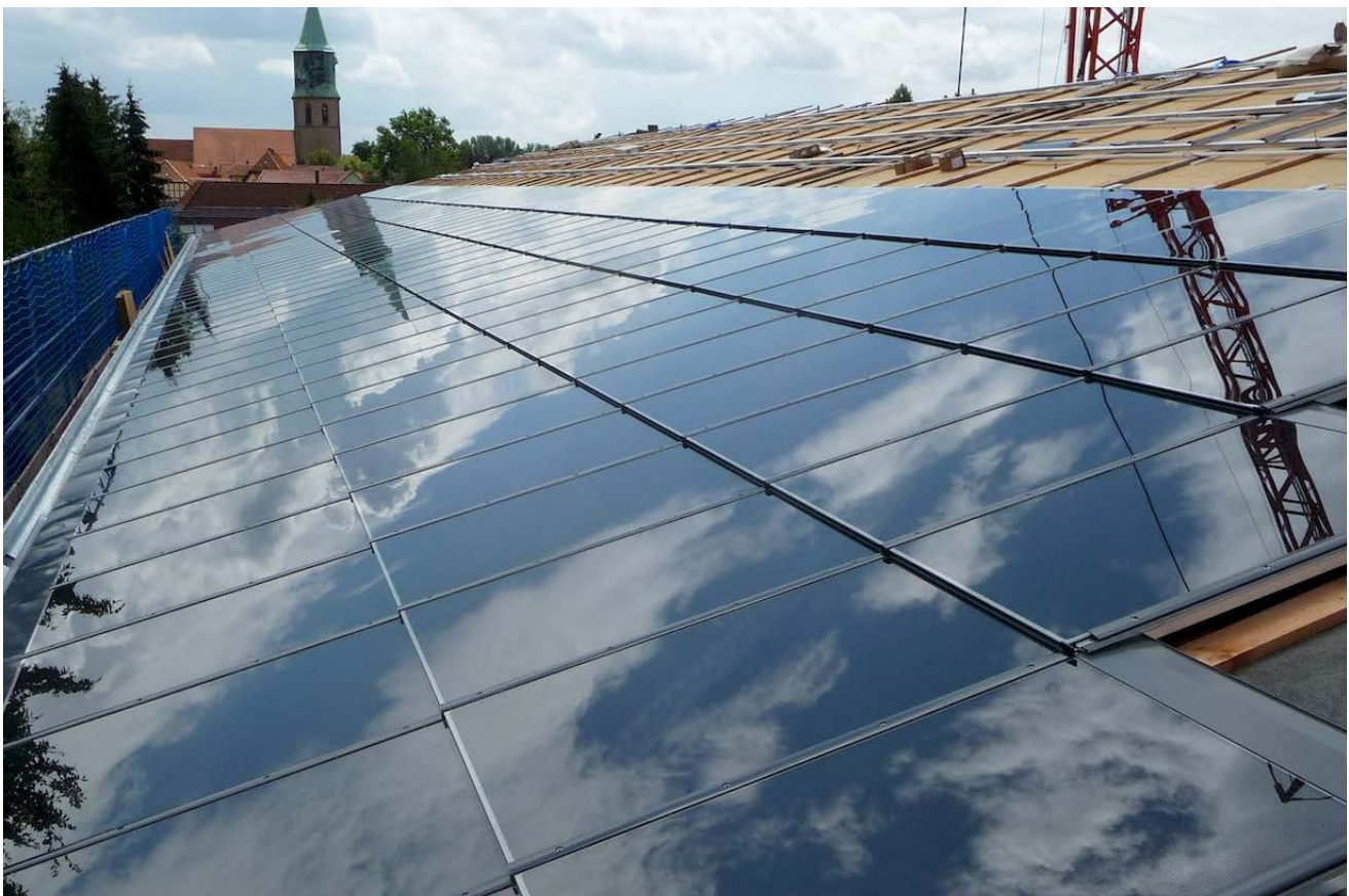
Abb. 7.1.2.2-01: Dachdeckungselement mit CIGS Modulen, nD-Indachsystem, nD-System GmbH
