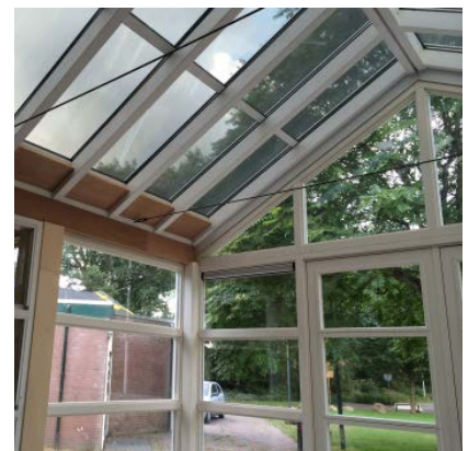
Abb. 7.5-01: Wintergartenverglasung mit semitransparenten CdTe-Modulen, Graz
