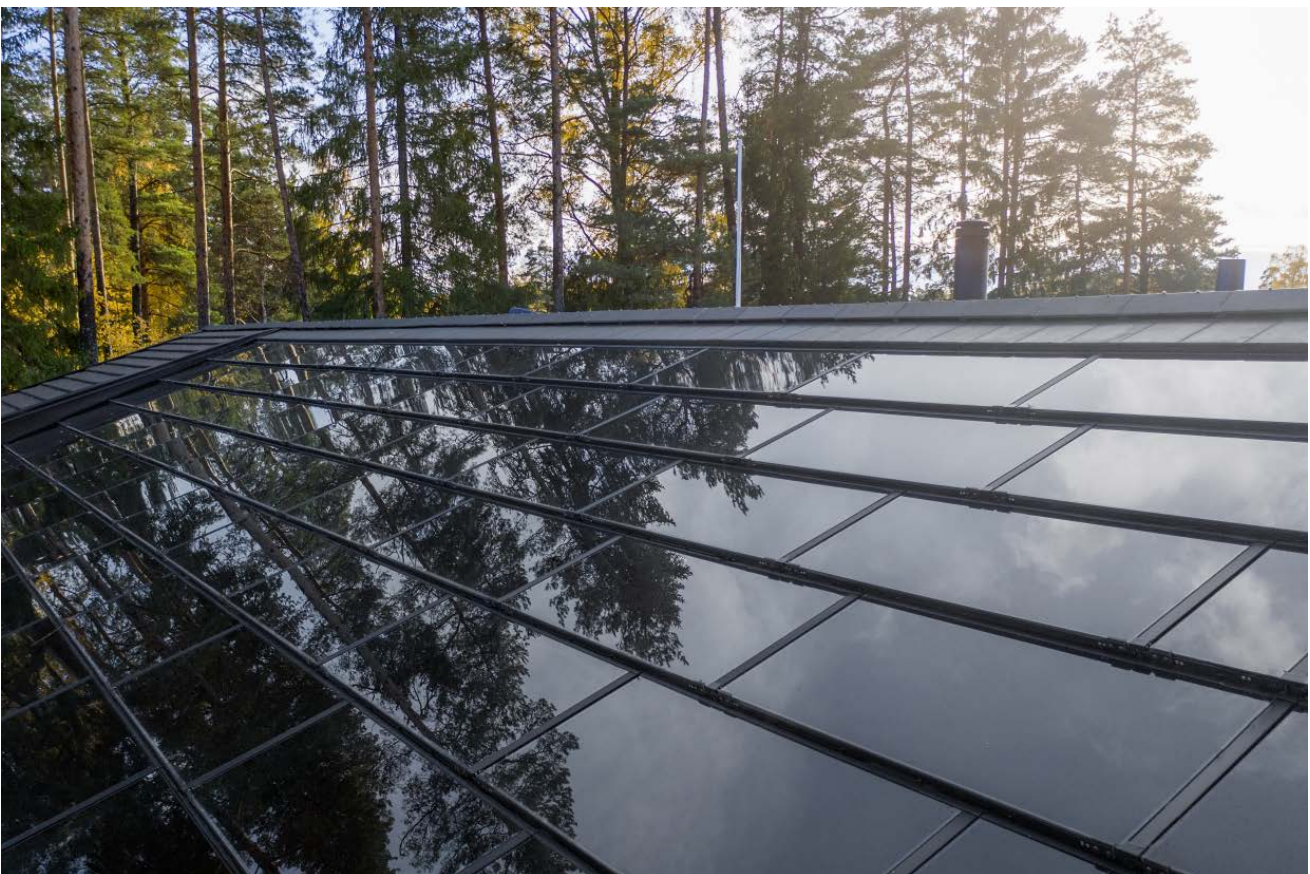
Abb. 7.1.2.2-04: Detail der Dachdeckung mit CdTe-Dachziegeln des Typs soltech RooF®
