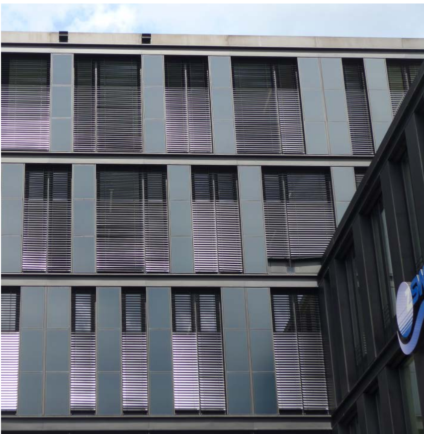
Abb. 4.3.2-13: CIGS-Fassadenverkleidung des ZSW, Stuttgart mit „PV-Framed Facade System“, NICE Solar Energy, 29 kWp, 256 m 2
