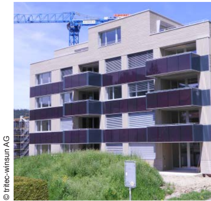
Abb. 2.2-08: PV-Balkonbrüstungen und Fassadenverkleidung (a-Si), Solarsiedlung Hintere Lugeten, Einsiedeln, Schweiz
