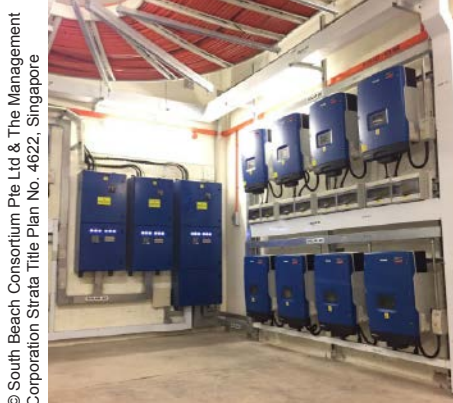
Abb. 8.2-09: Wechselrichter Wand 1
