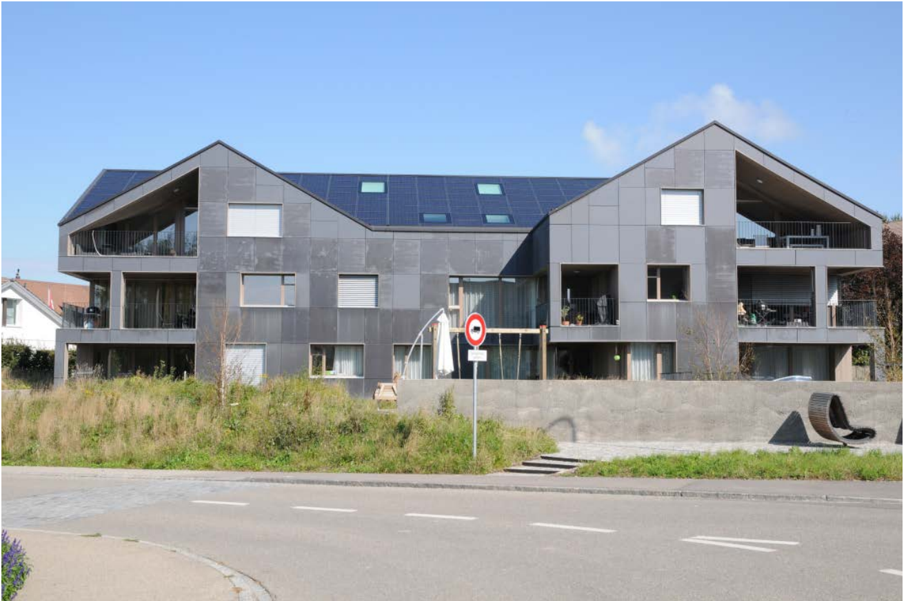
Abb. 5.3-02: Mehrfamilienhaus Brütten, Schweiz, mit einer Fassadenverkleidung aus rahmenlosen micromorphe Dünnschichtsolarmodule (Fassade: 47 kWp, 485 m 2 ) und einer Dacheindeckung mit Monokristallinen PV-Modulen (80 kWp, 512 m 2 )
