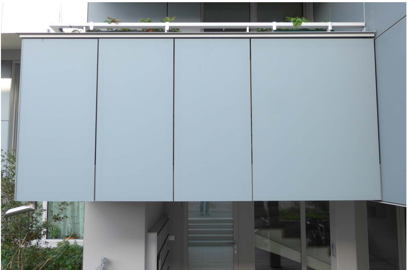
Abb. 5.6-04: Detail Brüstung. Das dahinter liegende PV-Zellenmaterial kann man auch aus der Nähe nicht erkennen
