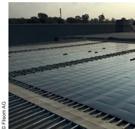
Abb. 6.1-03: CIGS-eFLex ® -Module auf Blechdach aufgeklebt
