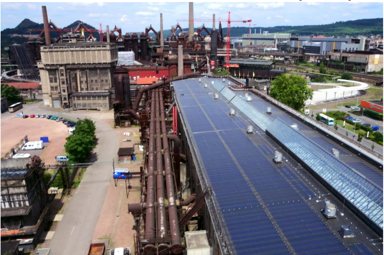
Abb. 7.2.3-03: Denkmalschutz-kompatible schwarze Solardachbahn (a-Si) für das Dach der Gebläsehalle, Völklinger Hütte, Völklingen (UNESCO Weltkulturerbestätte)
