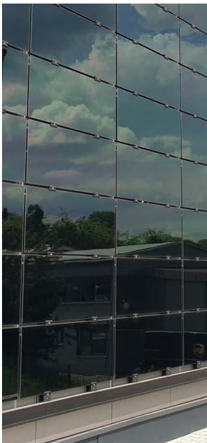
Abb. 4.3.3-02: Fassadenverkleidung mit CdTe-Modulen von Sanko Solar, 77kWp
