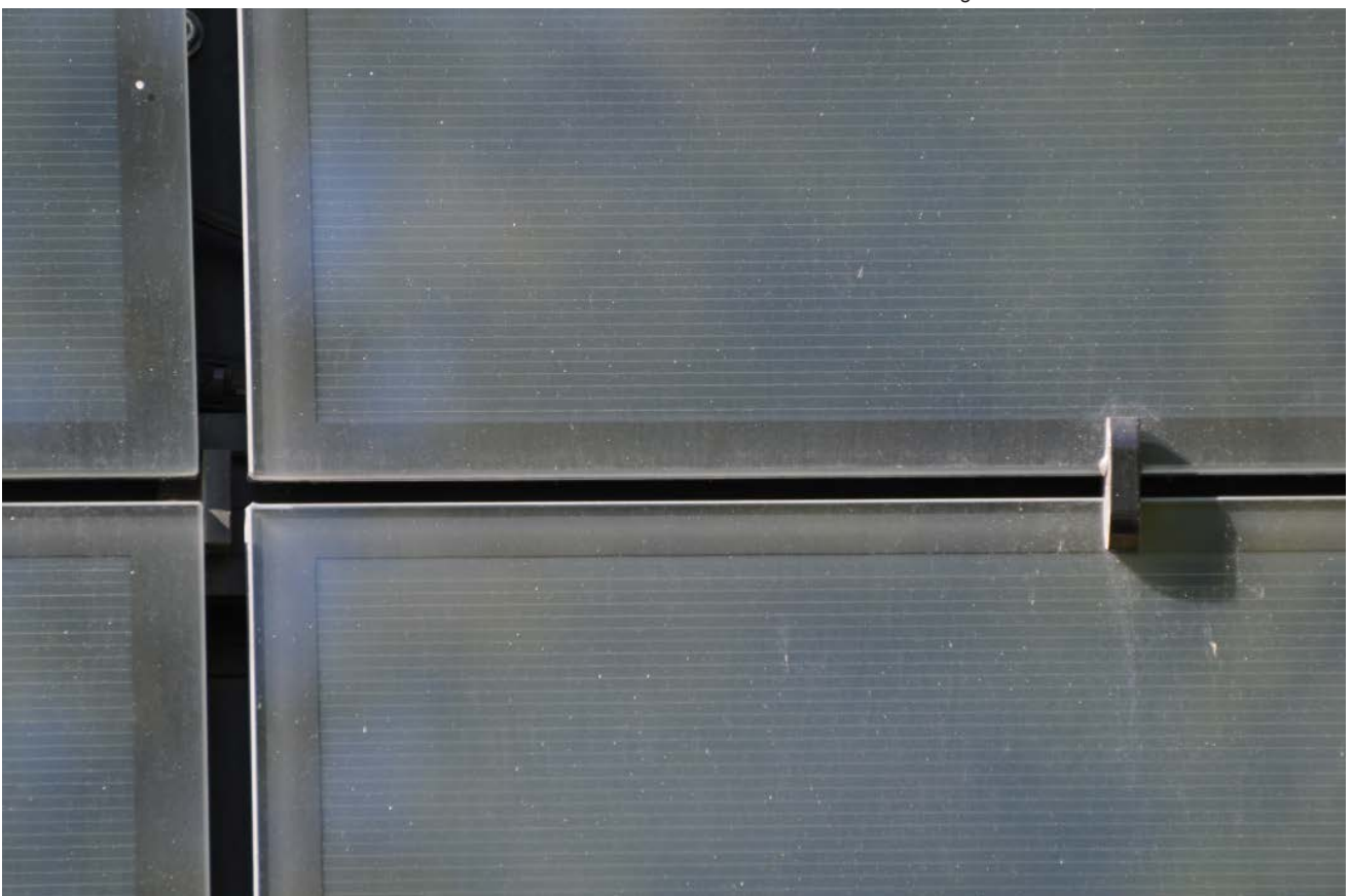
Abb. 7.3.2.2-14: Detail PV-Module und Halteklammer
