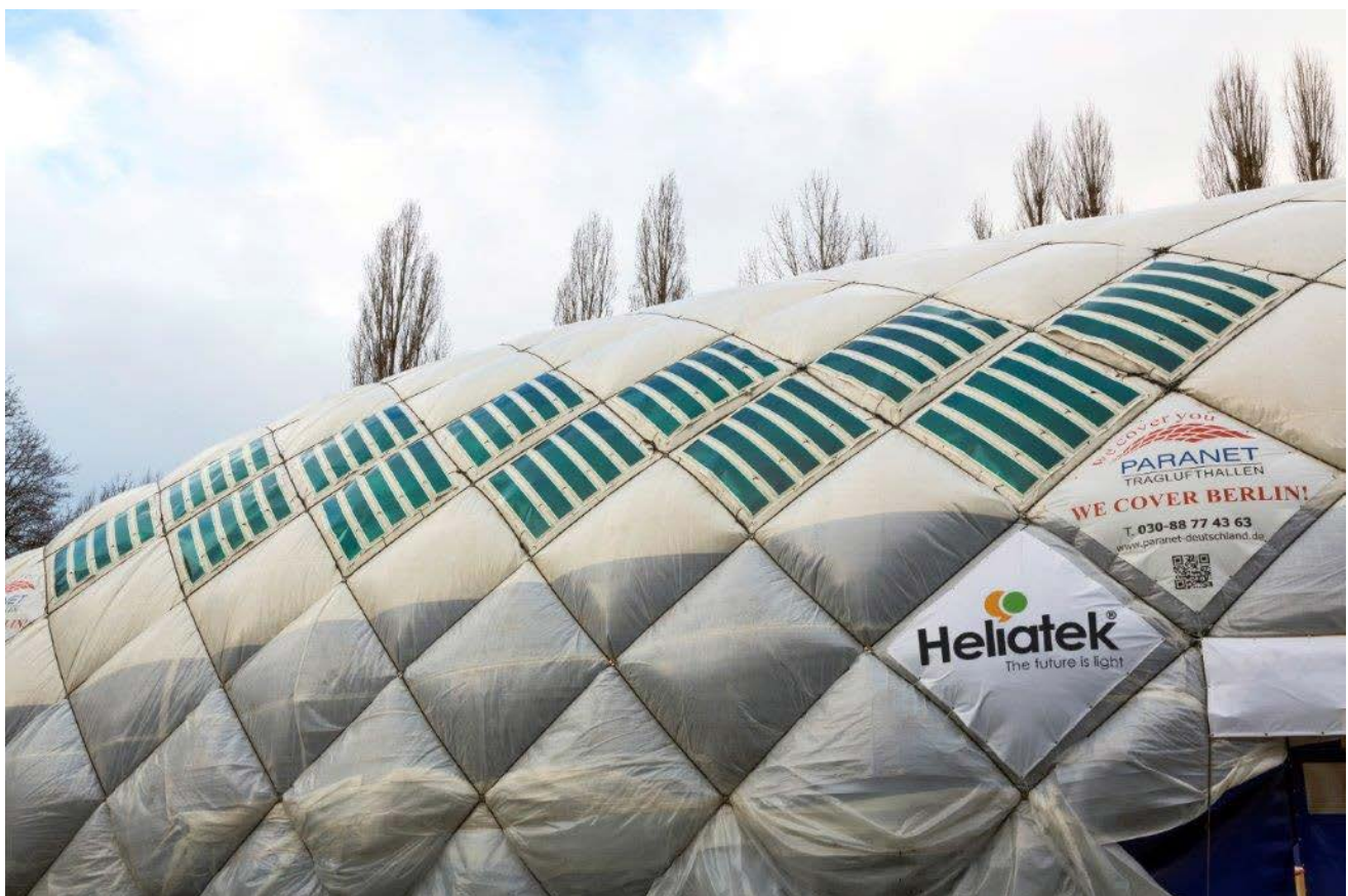
Abb. 7.7.1-01: Traglufthalle der Berliner Stadtmission mit integrierten OPV-Modulen von Heliatek
