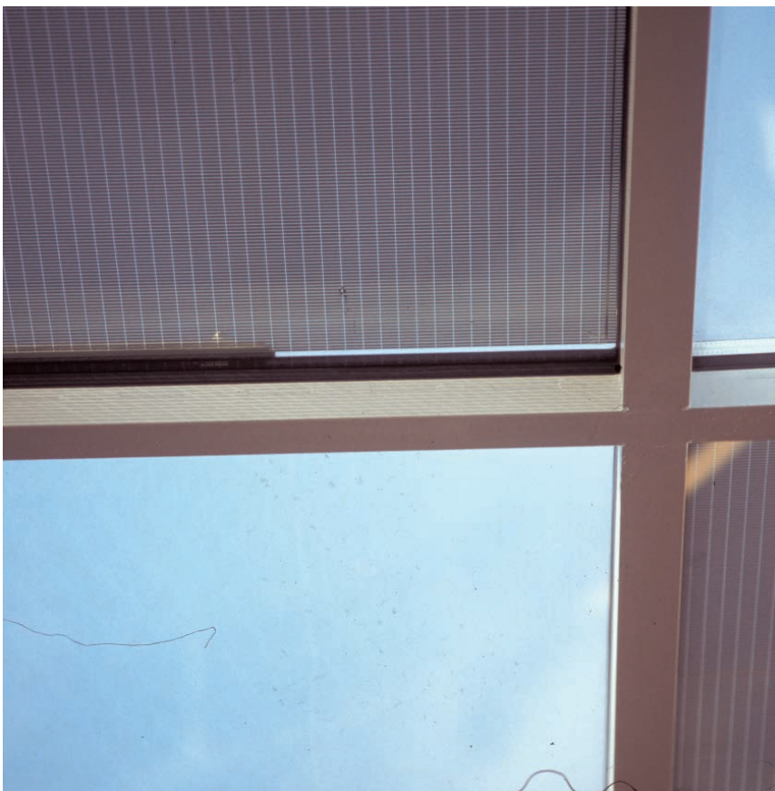
Abb. 7.5.2.4-16: Detailsicht Isolierglasmodule mit semitransparenten a-Si Modulen
