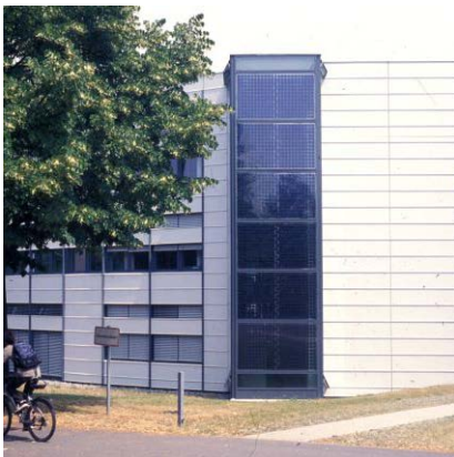
Abb. 3.4-06: PV-Fassade, Fraunhofer ISE, Freiburg
