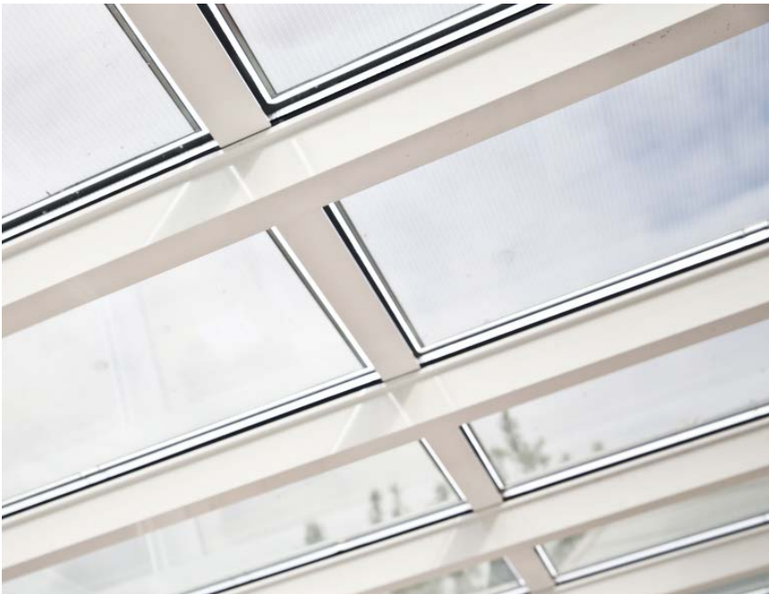
Abb. 4.3.3-03: Wintergartenverglasung mit semitransparenten CdTe-Modulen von Sanko Solar
