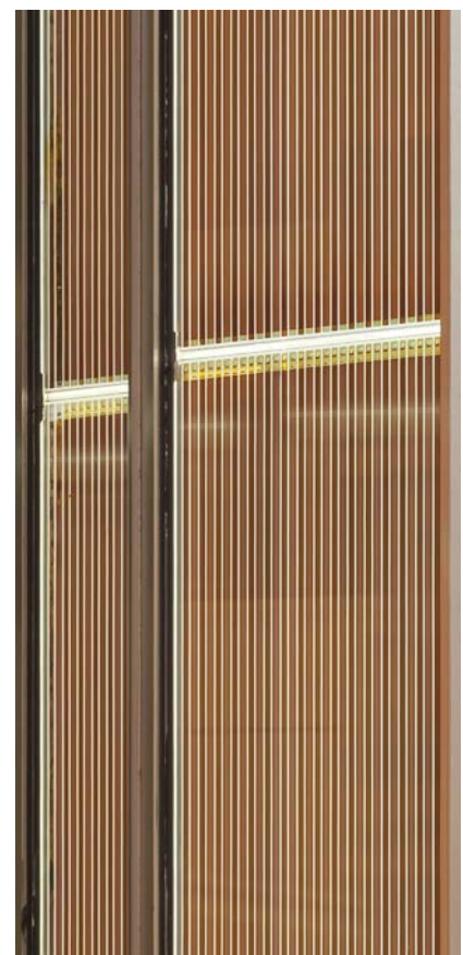
Abb. 7.6.2-09: Detail der in Glas eingebetteten Farbstoffsolarmodule WW
