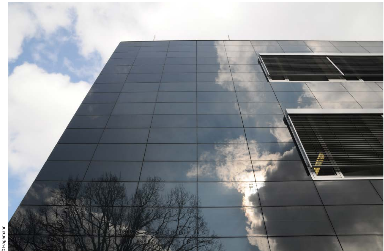
Abb. 4.3.2-11 CIGS-Fassadenverkleidung, Laborgebäude „Walther-Hempel-Bau“, TU Dresden mit 777 rahmenlosen PV-Modulen, 58 kWp,
