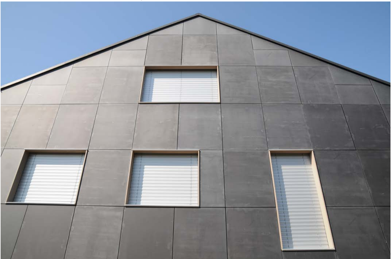
Abb. 5.3-03: Detail Fassadenverkleidung mit gesandstrahlten Dünnschichtmodulen
