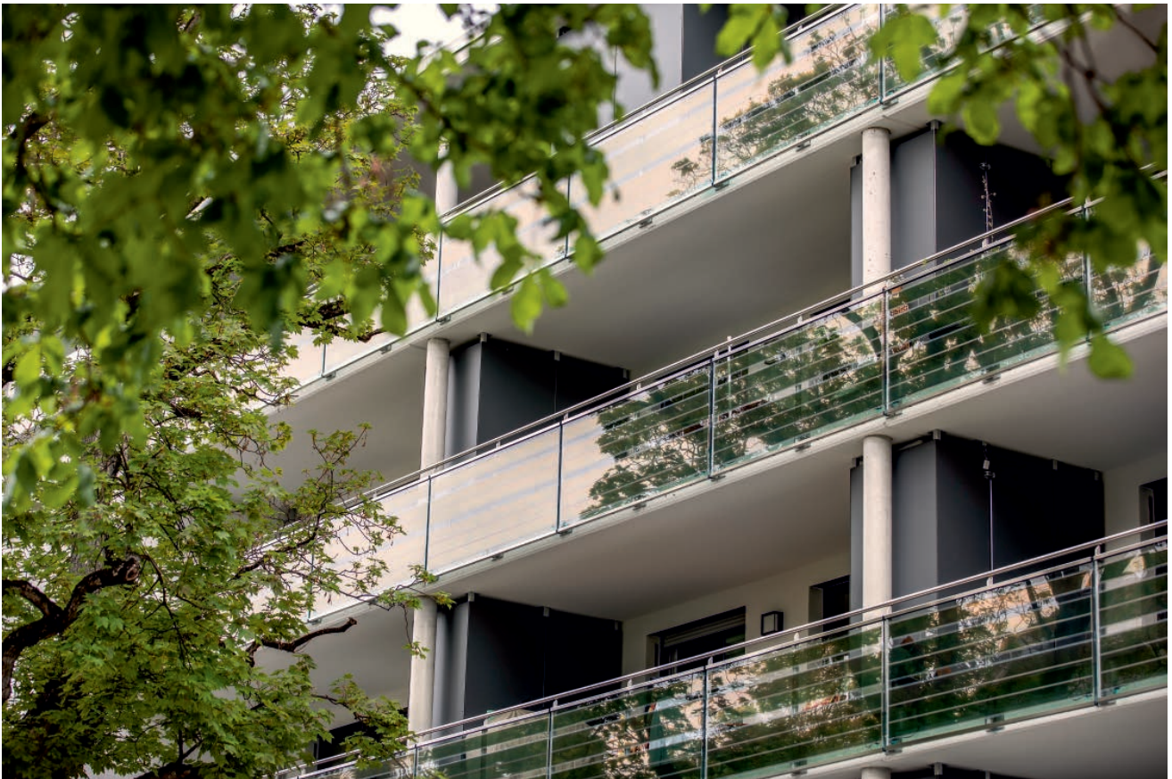
Abb. 7.4-05: Fassadenausschnitt mit Brüstungselementen aus Glas und integrierter OPV
