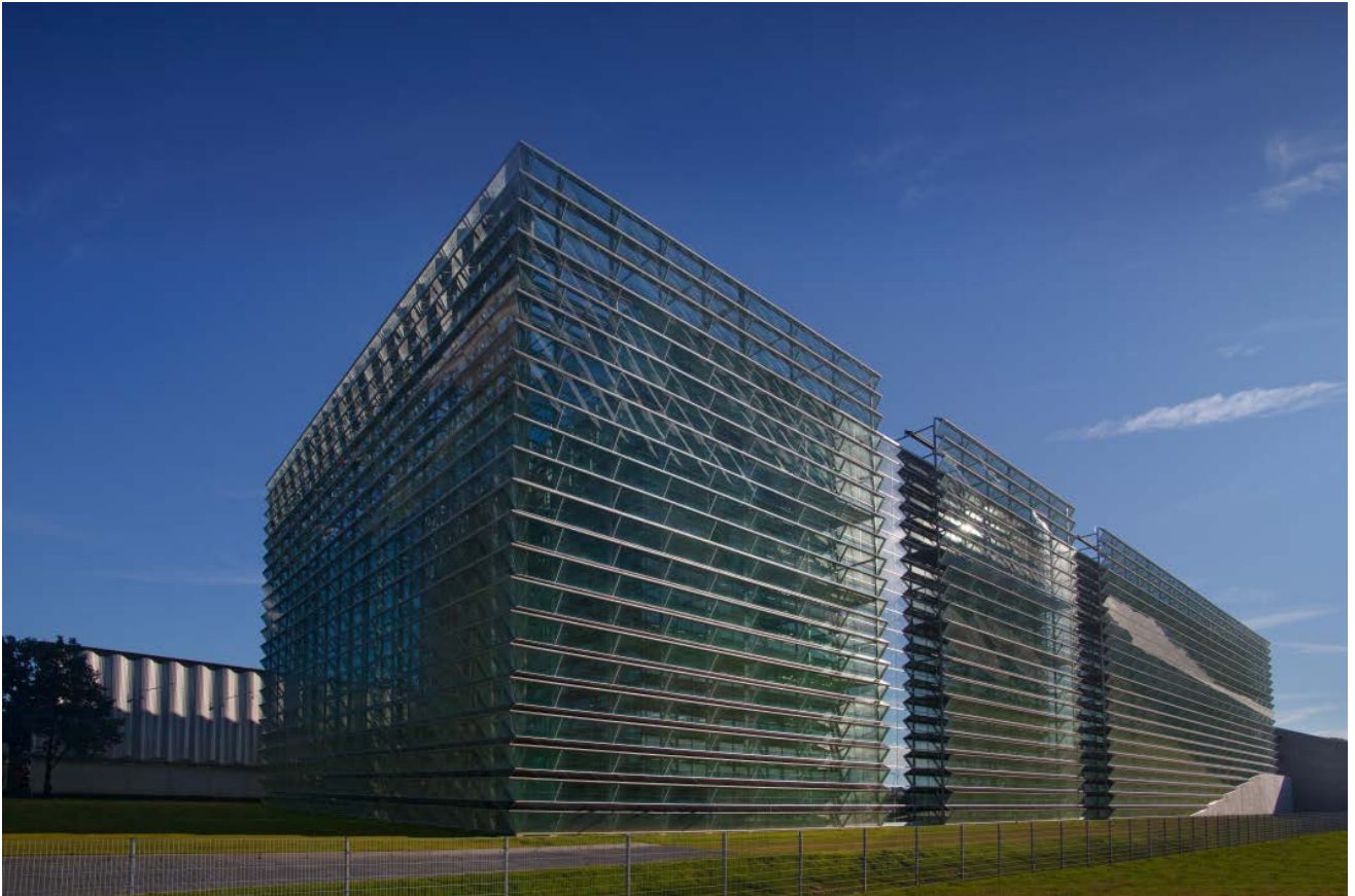
Abb. 7.6.1-03: Hochregallager mit Zick-Zack-Sonnenschutz aus CIGS-Modulen und Crash-Glas, Ernsting's family GmbH & Co. KG, Coesfeld
