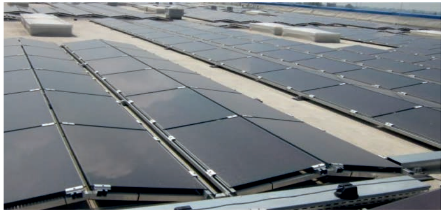
Abb. 7.2.1-03: OST-West ausgerichtete PV-Dachaufständerung mit a-Si-Glasmodulen, Flachdach-Montagesysteme der Arausol-Arau Technik GmbH
