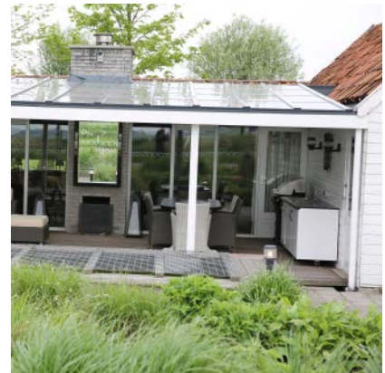
Abb. 7.5.2.4-01: CdTe-Überkopfverglasung, Objekt Grijpskerk, Niederlande, 3,24 kWp
