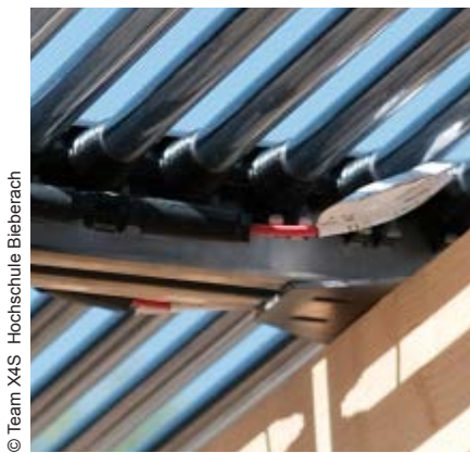
Abb. 7.6.1-08: Detail Montageplatte zwischen zwei Modulen sowie Verkabelung
