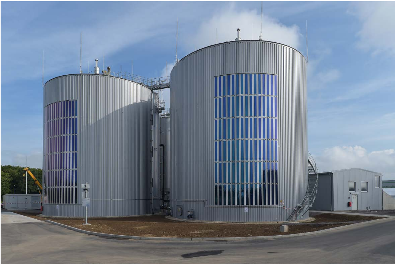
Abb. 7.3.1-04: Fermenter der RWE-Biogasanlage, Bergheim-Pfendorf, mit OPV-Modulen (HeliaFilm, Heliatek), 5,40 kWp
