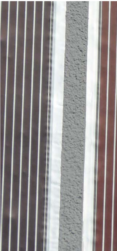
Abb. 7.3.3-01: Detail Fläche zwischen zwei OPV-Modulen
