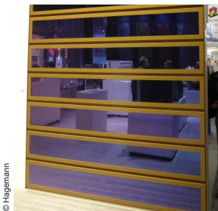
Abb. 7.3.2-01: Musterfassade aus Metallkassetten mit OPV-Modulen (Heliatec)
