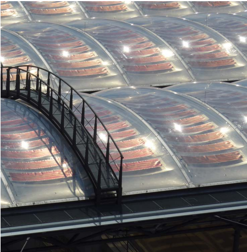
Abb. 7.7.2-05: Detailausschnitt ETFE-Dach mit a-Si-Modulen
